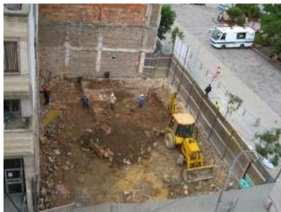
Excavaciones para cimentación.
