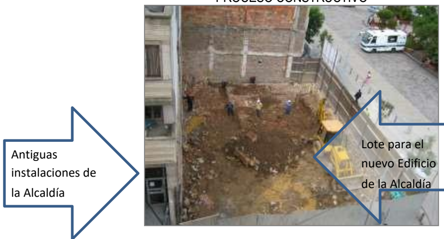
Inicio de la obra
