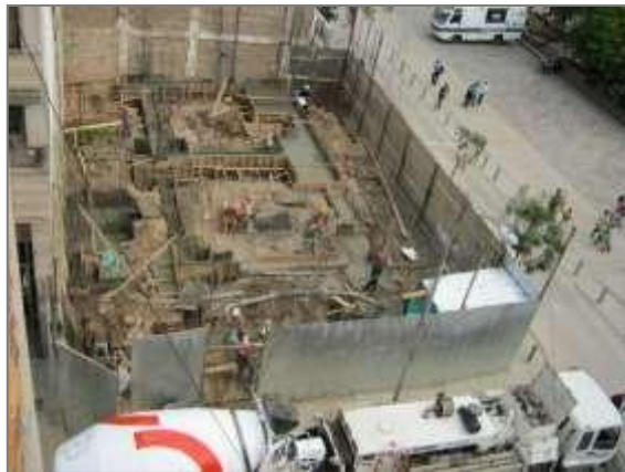
Fundición cimentación.
