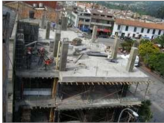
Fundición columnas +5.88M.
