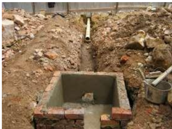
Excavación para acometidas sanitarias.
