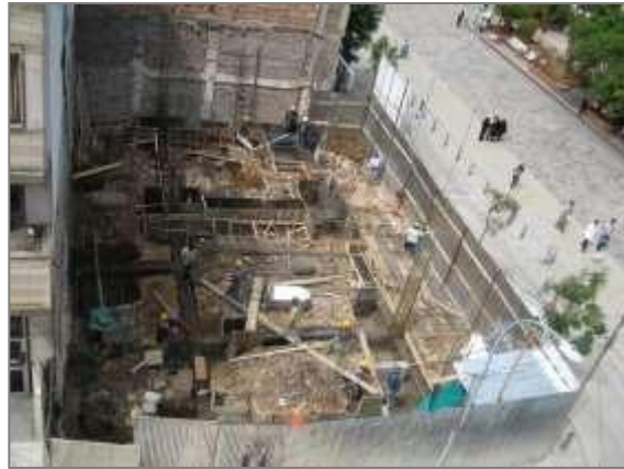
Amarre acero de refuerzo cimentación.
