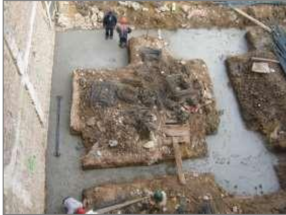
Concreto de limpieza.
