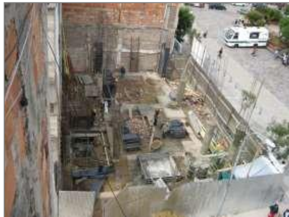
Fundición columnas nivel +0.00M.
