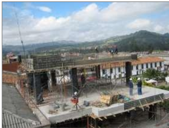
Desencofre vigas aéreas nivel 15.34M.
