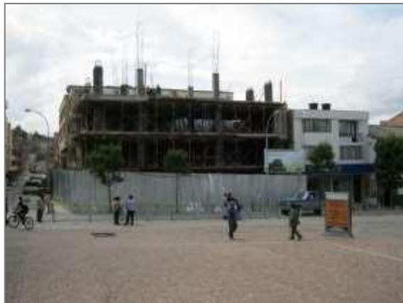
Fundición nivel +5.88M.
