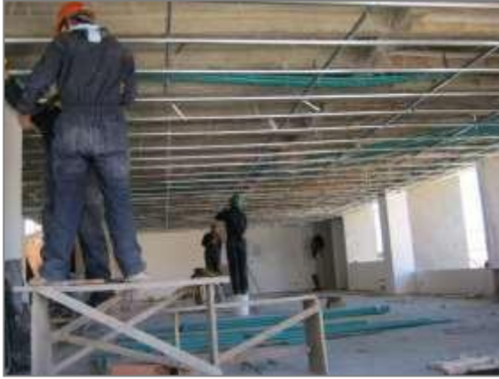
Instalación estructura dry wall nivel +8.81M.
