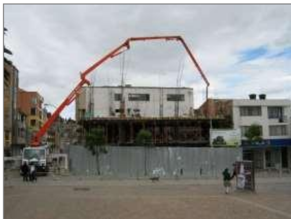
Fundición placa nivel +5.88M.
