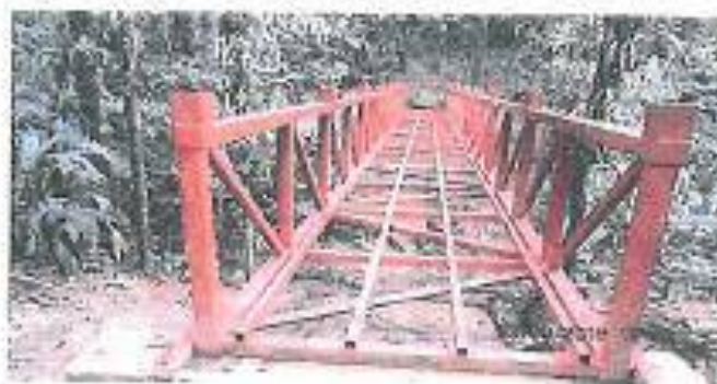
12. CONSTRUCCION DE PUENTE CORTO No 2.
