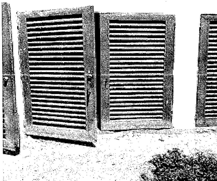
**Imagen 11:** Estado de la Carpintería metálica sin terminar en cuartos técnicos.
