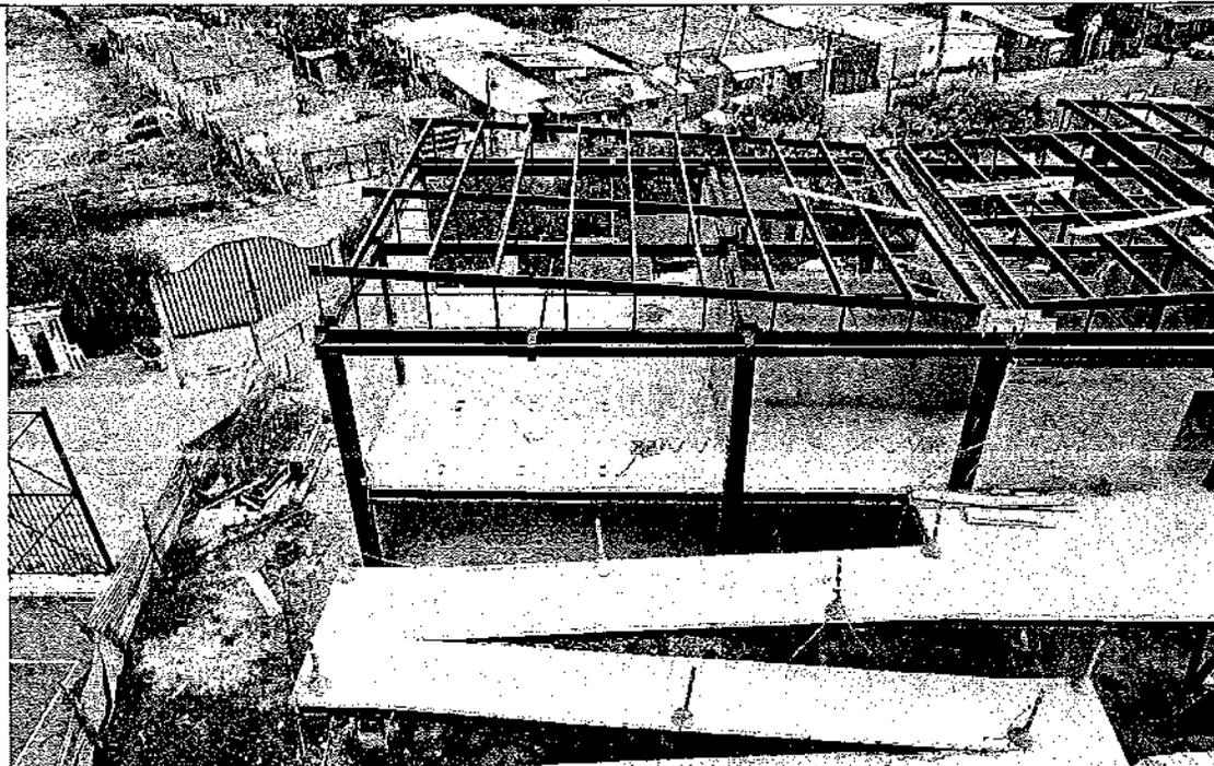
**Imagen 10:** Rampa y estado de la estructura metálica y la mampostería instalada del proyecto Edificio Administrativo Institución Educativa Departamental de la Vereda Parcelas del Municipio de Cota- Cundinamarca.
