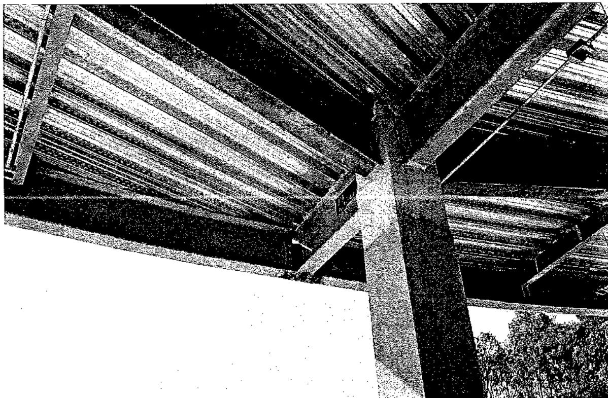
**Imagen 10:** Remate superior unión columnas en concreto y estructura entre piso área del semisótano.
