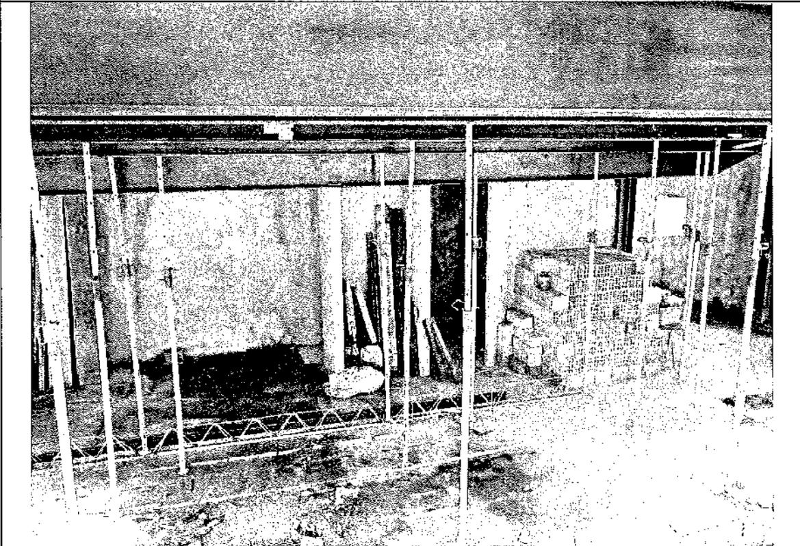
**Imagen 10:** Apuntalamiento placa de entresuelo y estado placa de contrapiso del Edificio Multifuncional en el área central del Municipio de Cota- Cundinamarca.
