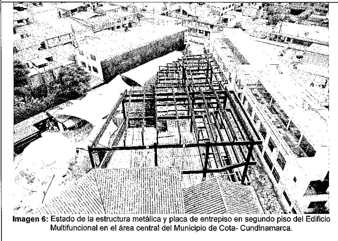
**Imagen 6:** Estado de la estructura metálica y placa de entpiso en segundo piso del Edificio Multifuncional en el área central del Municipio de Cota- Cundinamarca.
