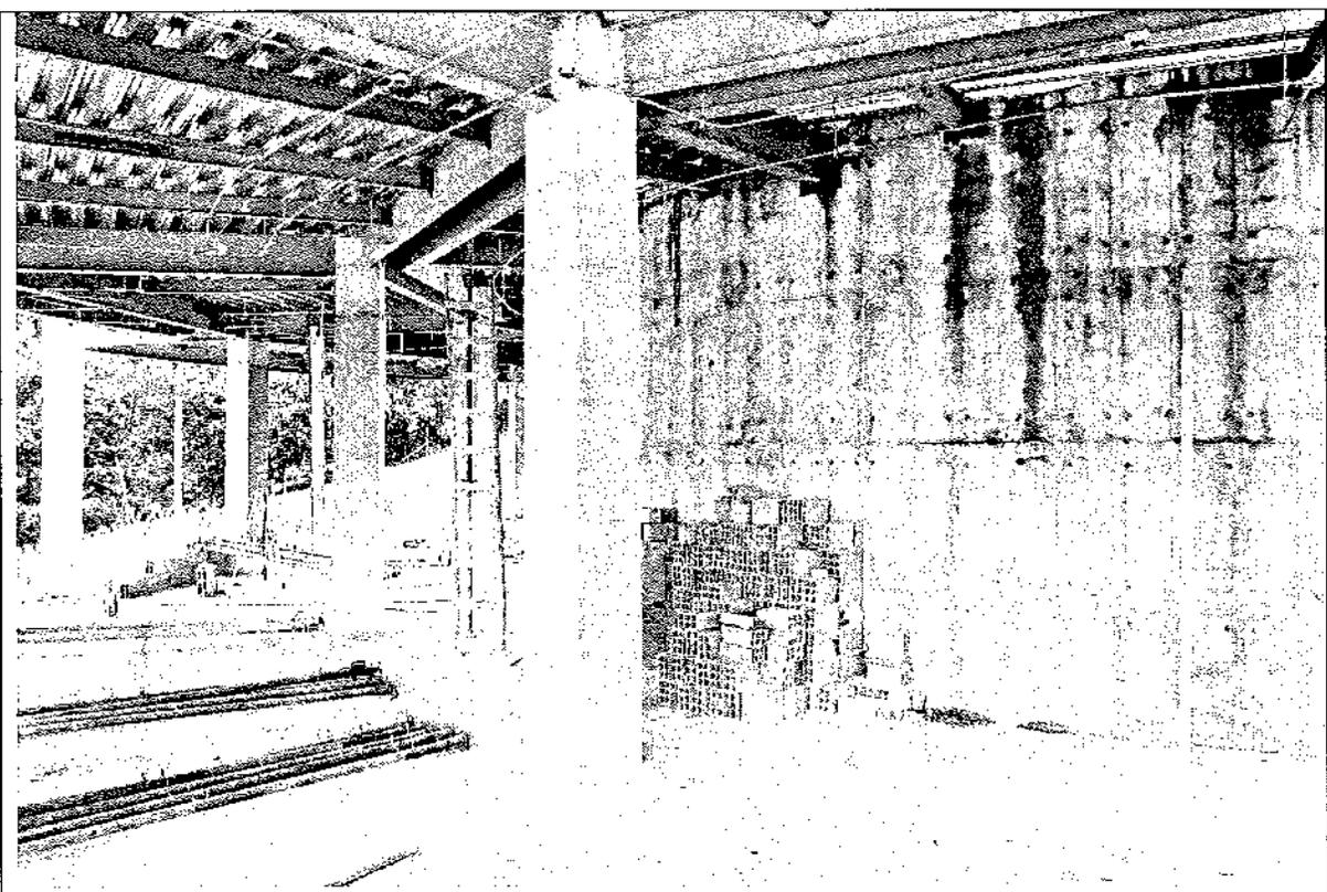
**Imagen 8:** Remate superior unión columnas en concreto y estructura entrepiso área del semisótano.
