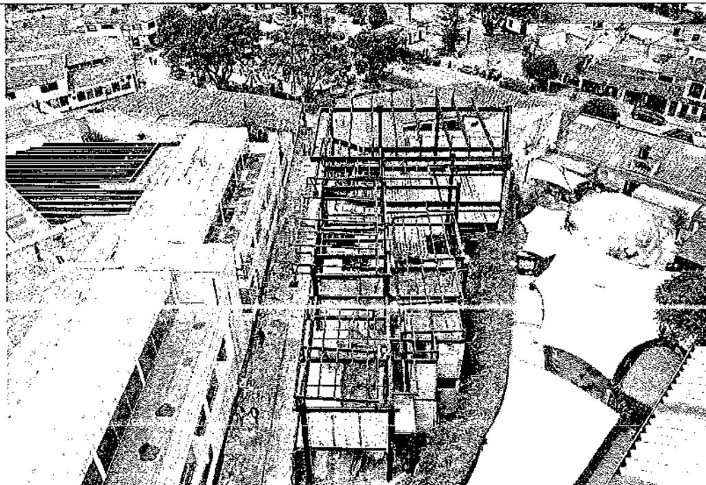
**Imagen 4:** Estado de la estructura metálica y mampostería en segundo piso del Edificio Multifuncional en el área central del Municipio de Cota- Cundinamarca.
