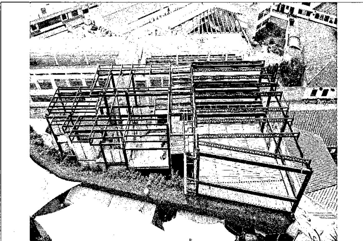
**Imagen 5:** Estado de la estructura metálica, mampostería y placa de entpiso en segundo piso del Edificio Multifuncional en el área central del Municipio de Cota- Cundinamarca.
