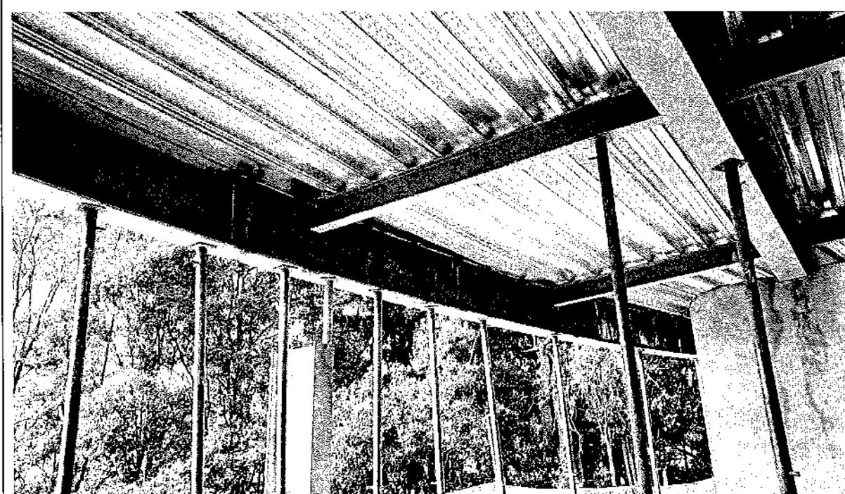
**Imagen 9:** Refuerzo de sección viga metálica IPE 500 de borde, con platinas de 12 mm de espesor.
