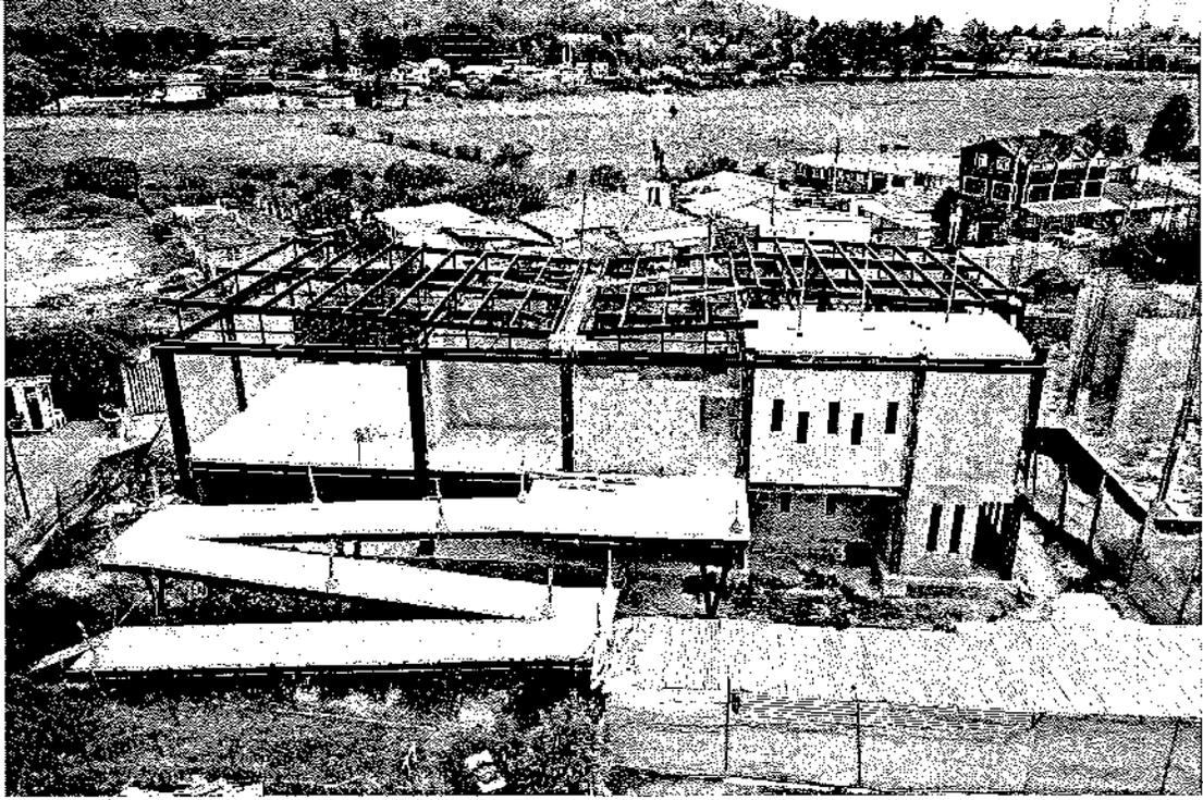
**Imagen 3:** Rampa y estado de la estructura metálica y la mampostería instalada del proyecto Edificio Administrativo Institución Educativa Departamental de la Vereda Parcelas del Municipio de Cota- Cundinamarca.
