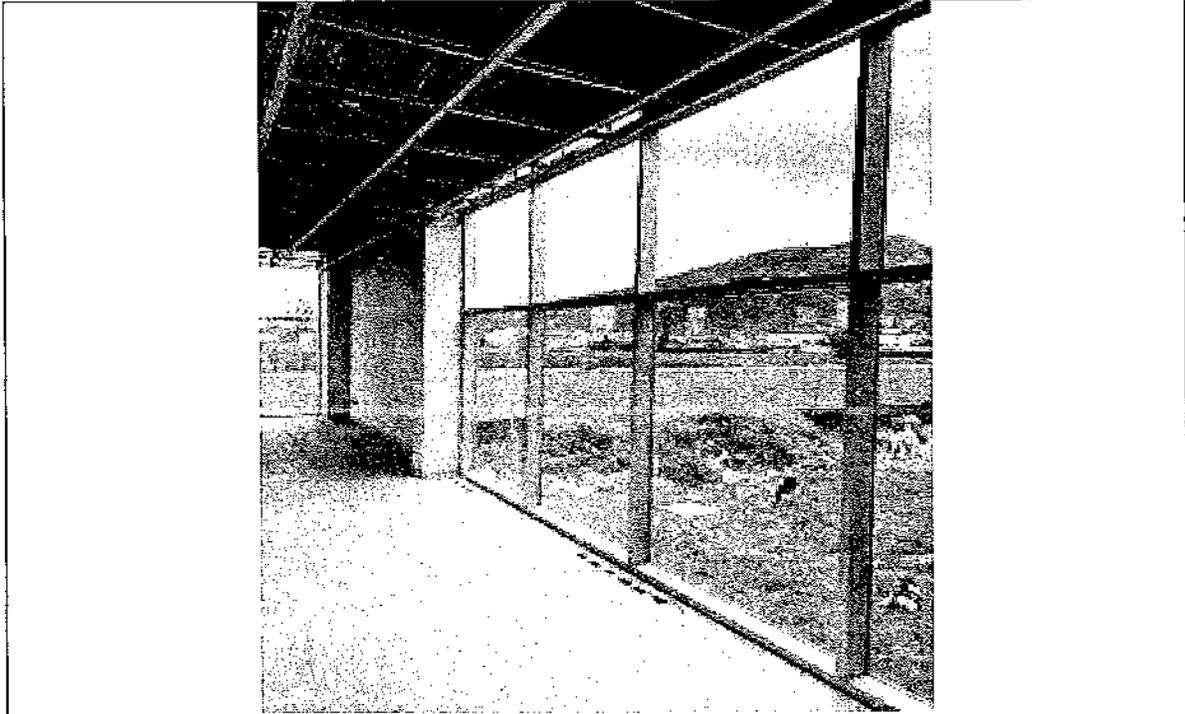
**Imagen 15:** La actividad de ventanería en aluminio no se ha terminado, está instalada la mayoría de la estructura, pero se encuentra pendiente la instalación del vidrio.
