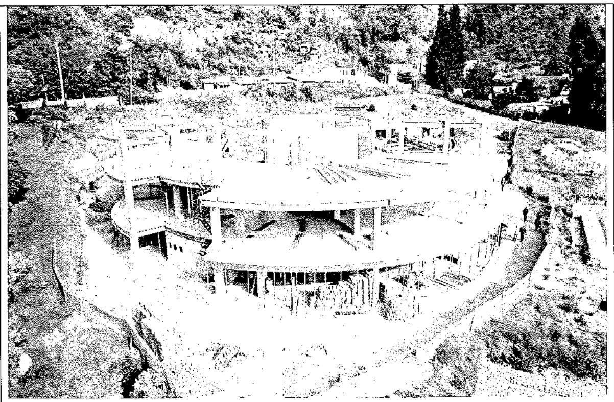
Imagen 4: Vista de la estructura metálica instalada y placas de entrepiso construidas del proyecto.
