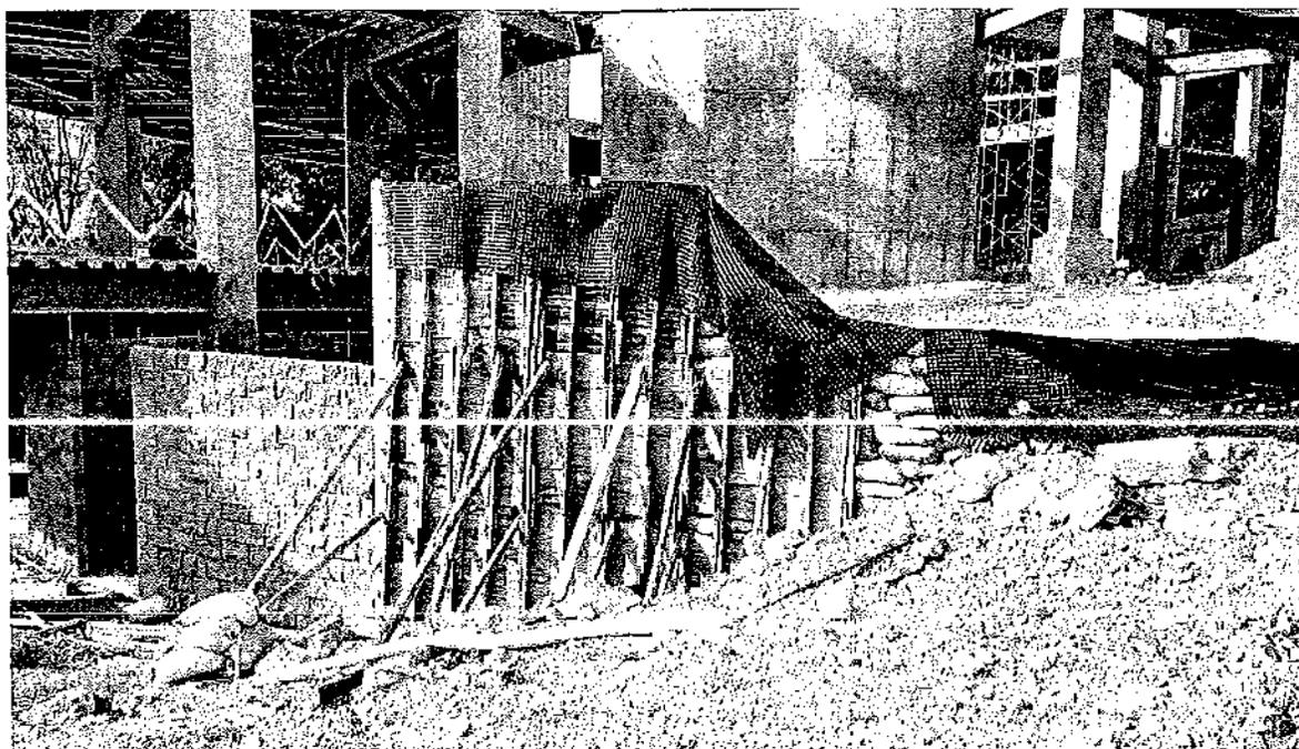
**Imagen 12:** Muro de confinamiento apuntalado para instalación de relleno área acceso primer piso.
