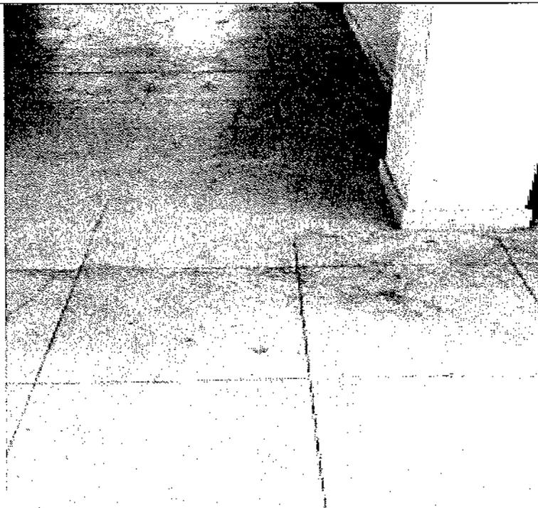
**Imagen 6:** Los pisos para circulaciones y oficinas son en cerámica tráfico 5, calidad primera. A la fecha la cerámica se encuentra con óxido generado por el agua que entra de las cubiertas y las fachadas sin terminar que mojan los elementos metálicos y éstos generan óxido.
