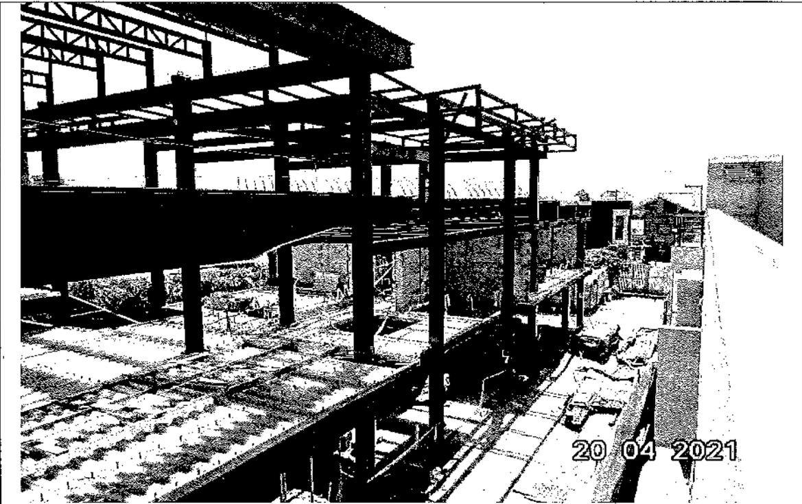
**Imagen 9:** Estado de la estructura metálica, placa de entresuelo y mampostería en el segundo piso del Edificio Multifuncional en el área central del Municipio de Cota- Cundinamarca.
