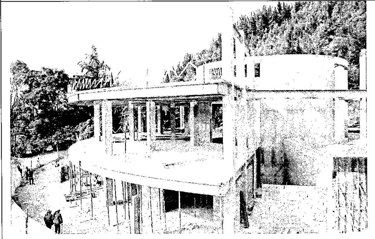
Imagen 5: Vista de la estructura metálica instalada y placas de entrepiso construidas del proyecto.
