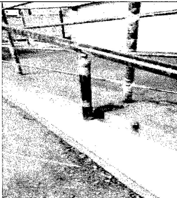
**Imagen 10:** Barandas con óxido ferroso por falta de cubierta y fachada.
