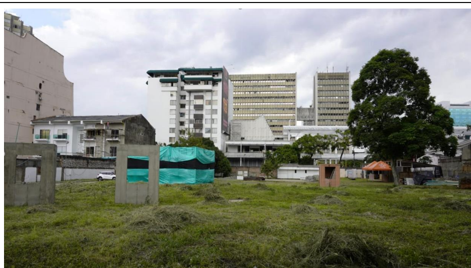
Fotografía 2. Estado actual del predio SENA en Avenida 4N – Cali.
