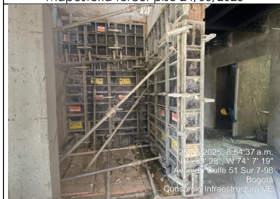
Armado de muros 18/07/2025
