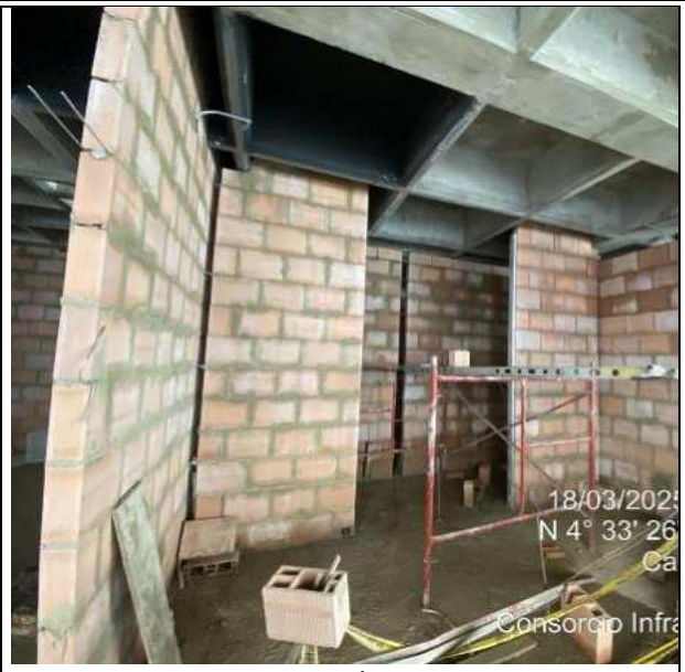
Armado de muros sótano 18/03/2025
