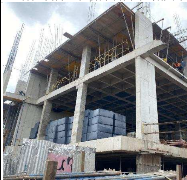
Armado de placa tercer piso 21/03/2025
