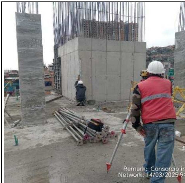
Fundida de pantallas y columnas 2 nivel 14/03/2025
