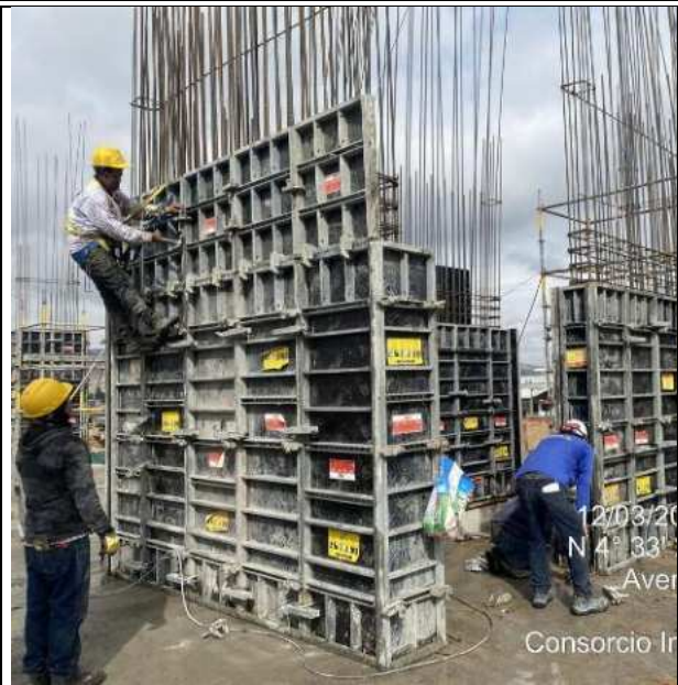
Armado de pantallas y columnas 2 nivel 12/03/2025
