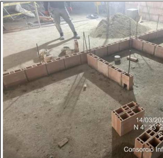
Armado muros en mampostería sótano 14/03/2025
