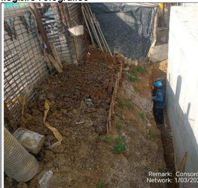
Excavación filtro perimetral 01/03/2025
