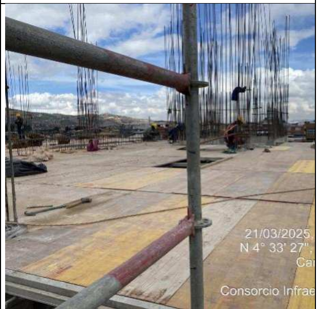
Armado de placa tercer piso 21/03/2025
