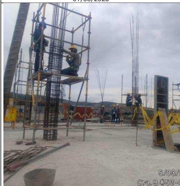
Armado columnas 2 nivel 05/03/2025
