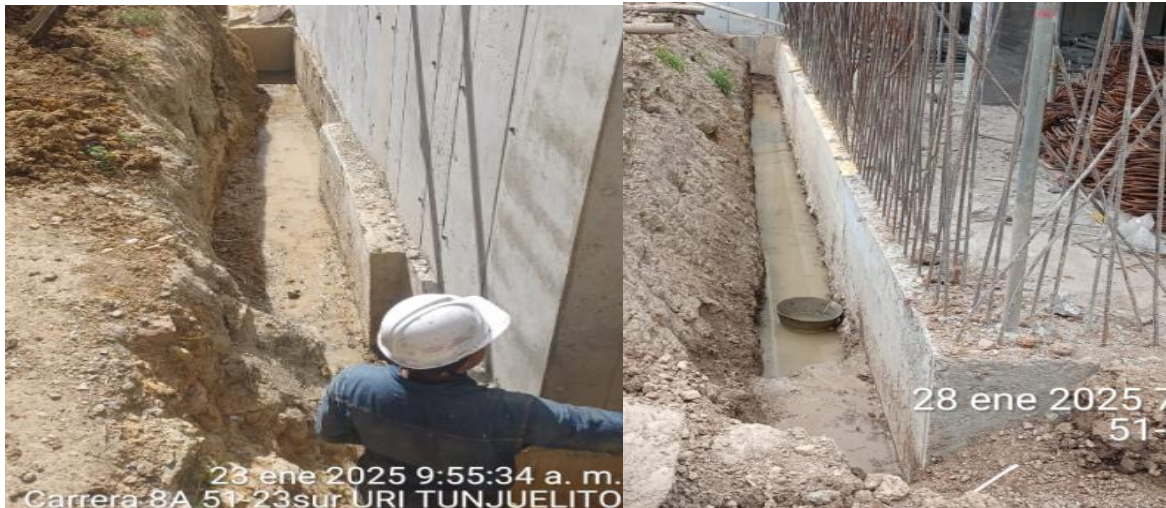
Excavación filtro perimetrales
