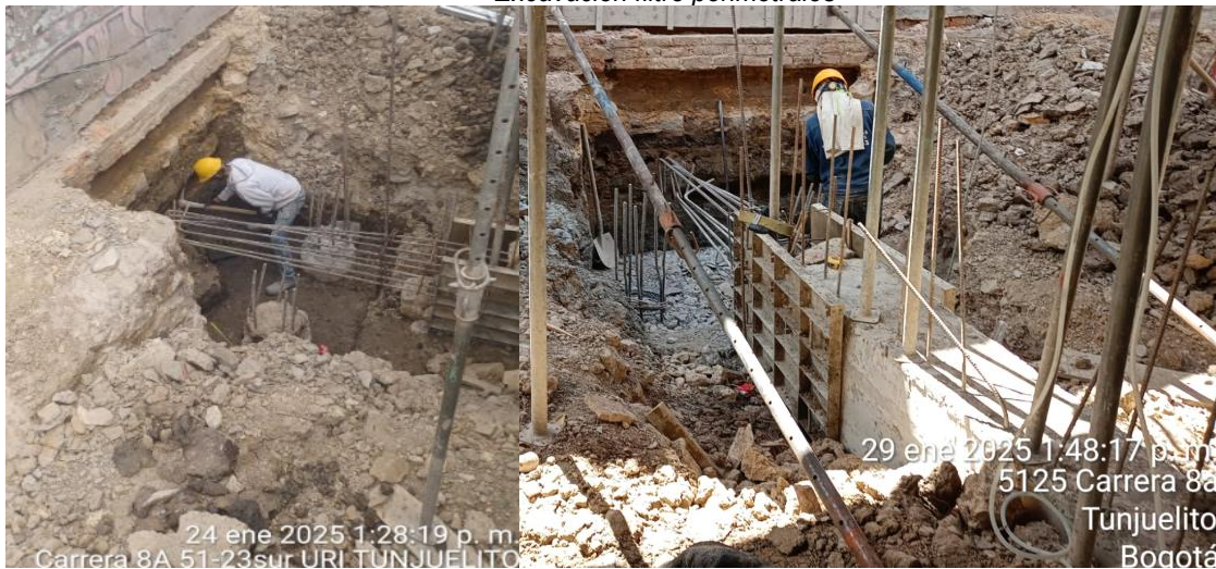
Excavación manual vigas y dados de cimentación
