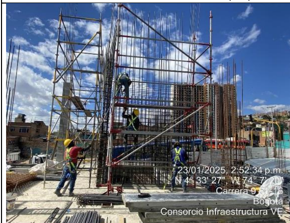
Armado de pantallas 1 nivel 23/01/2025
