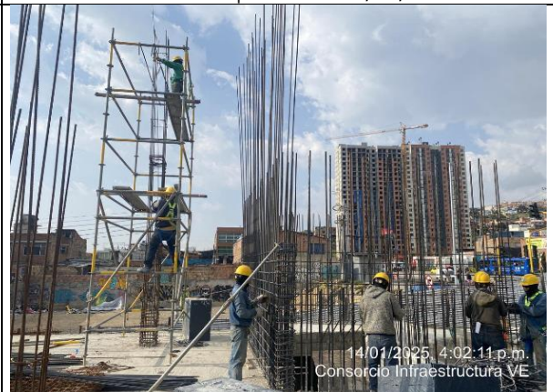
Armado de pantallas 1 nivel 14/01/2025
