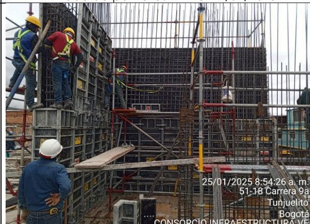
Armado de pantallas 1 nivel 25/01/2025
