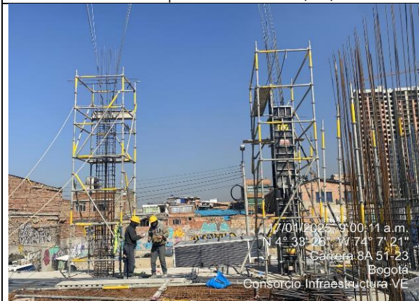
Armado de columnas 1 nivel 17/01/2025
