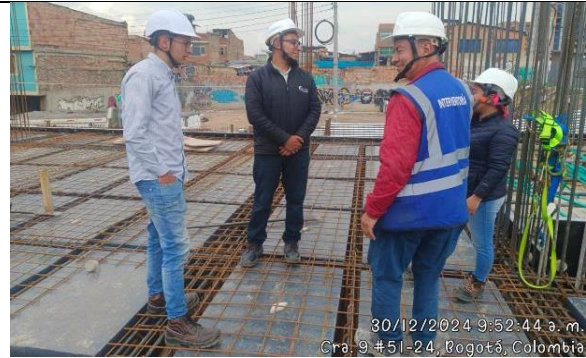
Armado de placa de N 0-005 30/12/2024
