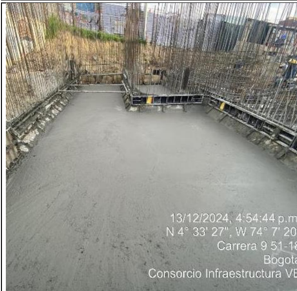
Fundida de placa de cimentación 13/12/2024
