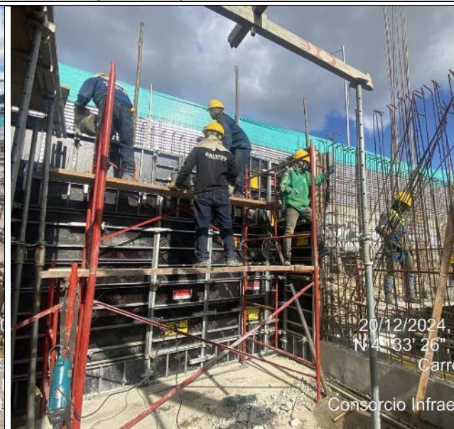
Armado de muros de contención 20/12/2024
