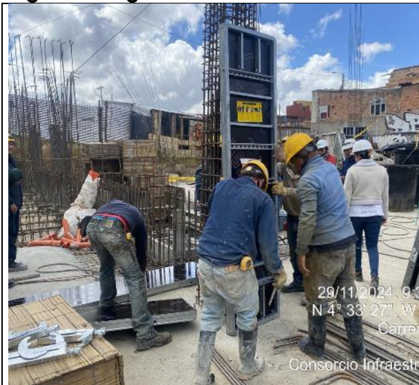
Armado muros de sótano 29/11/2024
