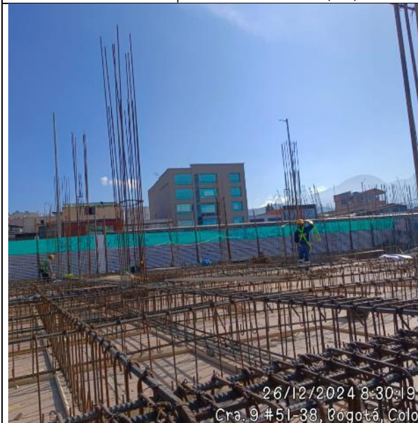
Armado de placa Nivel 0 26/12/2024
