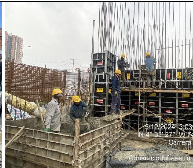
Fundida muros de sótano 05/12/2024
