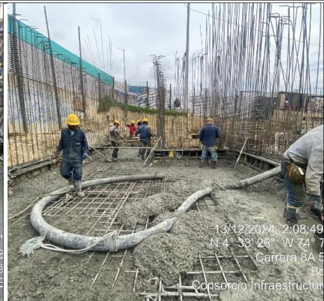
Fundida de placa de cimentación 13/12/2024
