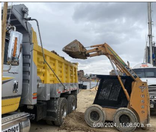
Cargue de material excavación
