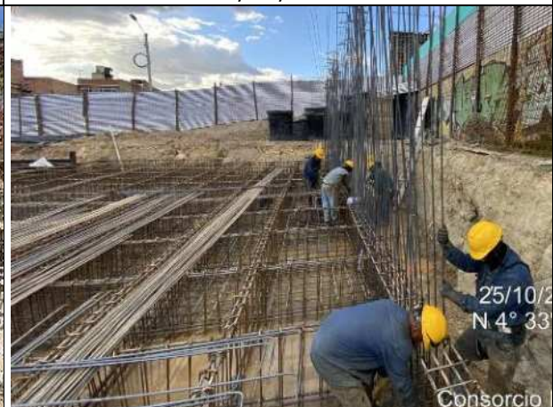
Armado de acero para cimentación 25/10/2024
