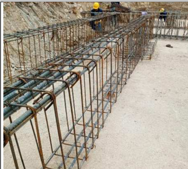
Armado de acero para vigas de cimentación 11/10/2024
