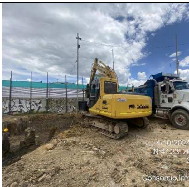
Excavación para conformación del sótano 4/10/2024
