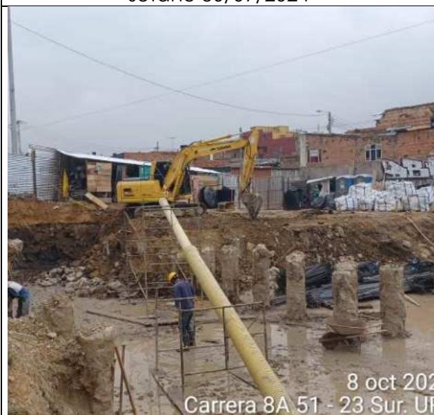
Excavación para conformación del sótano 8/10/2024
