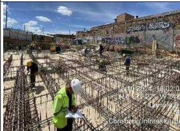
Armado de acero para cimentación 18/10/2024
