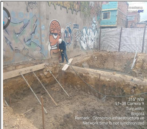
Excavación para sótano
