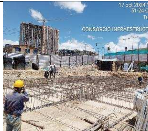
Armado de acero para cimentación 17/10/2024
