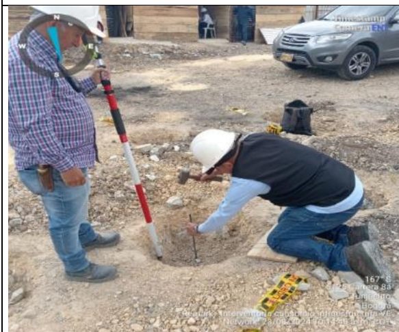
Localización y replanteo de pilotes
