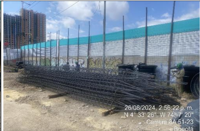
Armado de acero para estructura pilote
