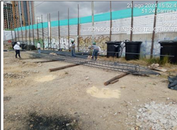
Armado de acero para estructura pilote
