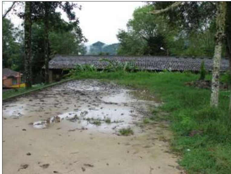
Imagen 6- Pista en arenilla y cuentas laterales sin desagües, ni filtros para la evacuación de las aguas lluvias.
