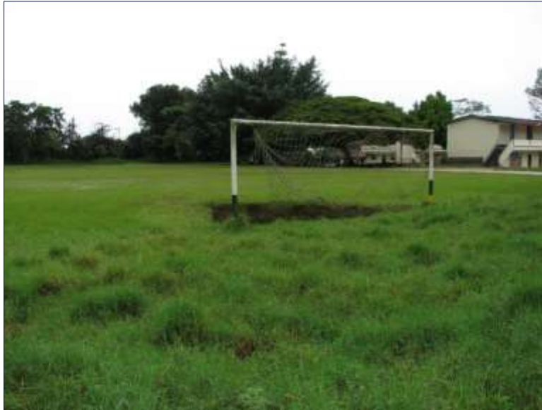
Imagen 5- Cancha con desniveles, por carencias de filtros y suelos saturados.
