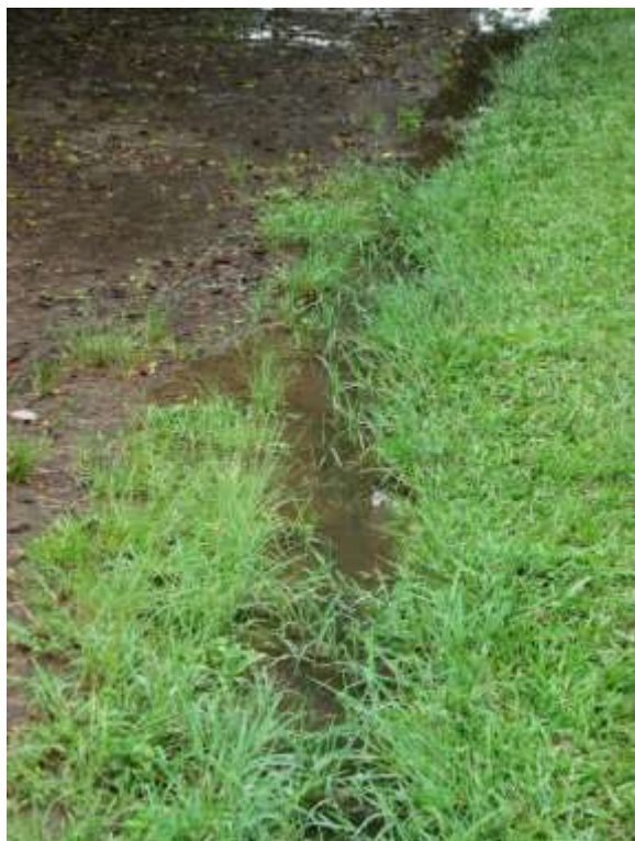
Imagen 4- Pista en arenilla y cuentas laterales sin desagües, ni filtros para la evacuación de las aguas lluvias.
