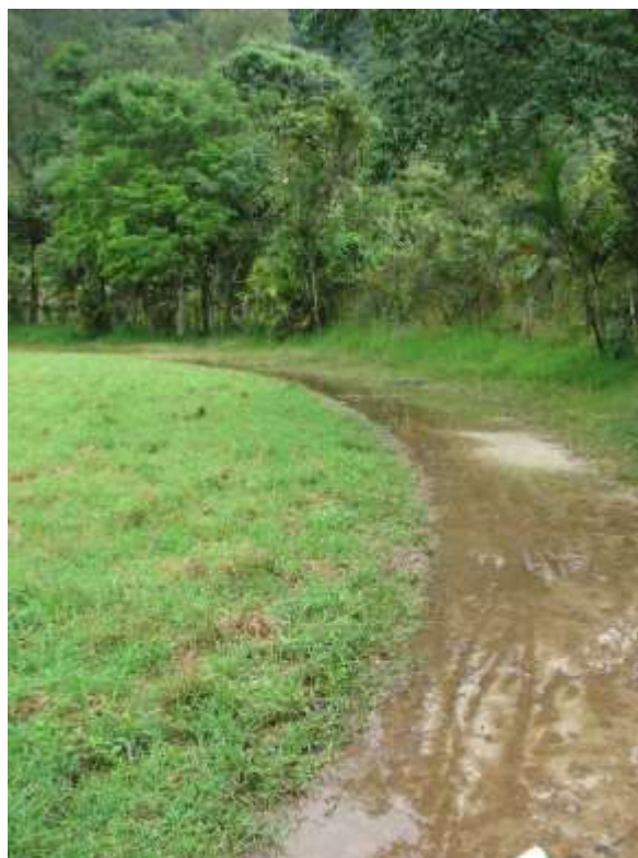
Imagen 2- Pista Inundada por falta de drenajes y filtros.
