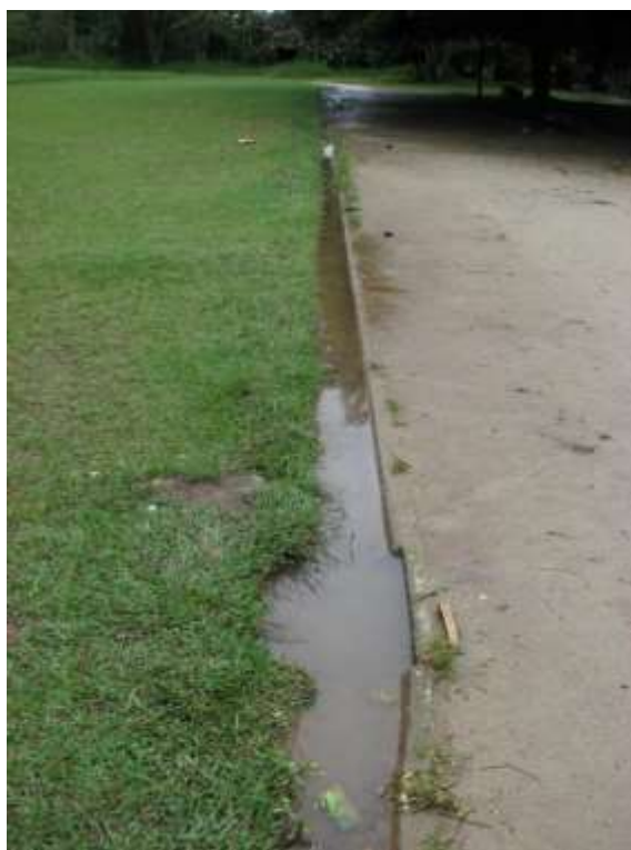
Imagen 4- Pista en arenilla y cuentas laterales sin desagües, ni filtros para la evacuación de las aguas lluvias.
