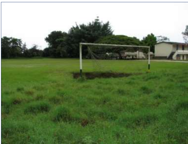
Imagen 5- Cancha con desniveles, por carencias de filtros y suelos saturados.
