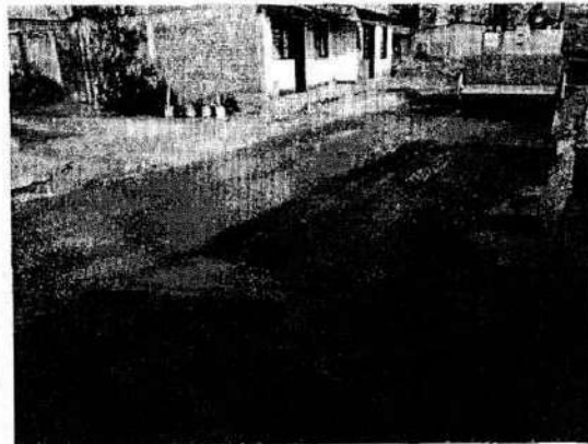
Figura 3 y Figura 4. Riego y compactación de base
