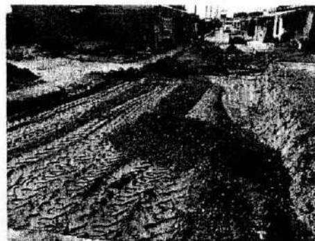
Figuras 1 y 2. Excavación y suministro de sub base
