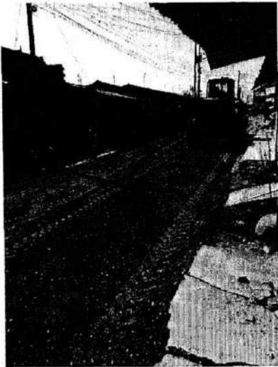
Figura 3 y Figura 4. Riego y compactación de base
