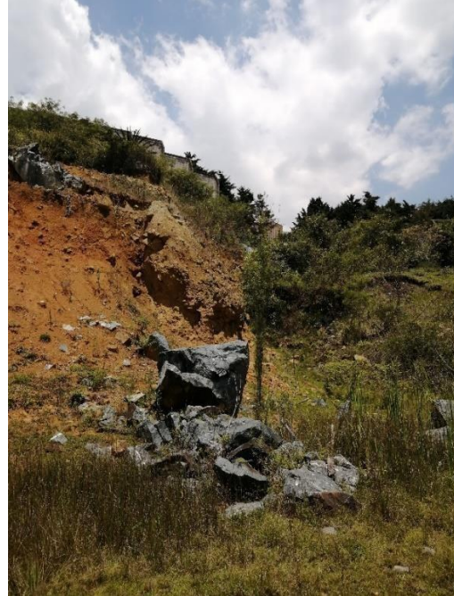
Falla de talud de corte costado norte Pola III
