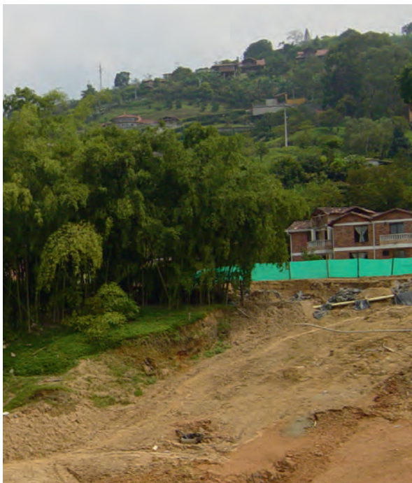
Corte de adecuación.
