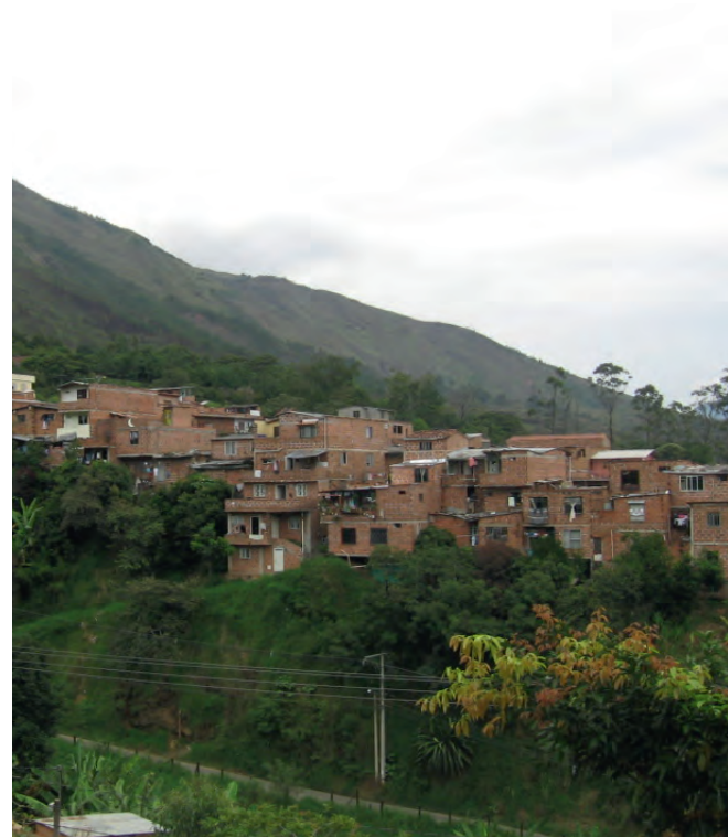
Alto riesgo geotécnico.
