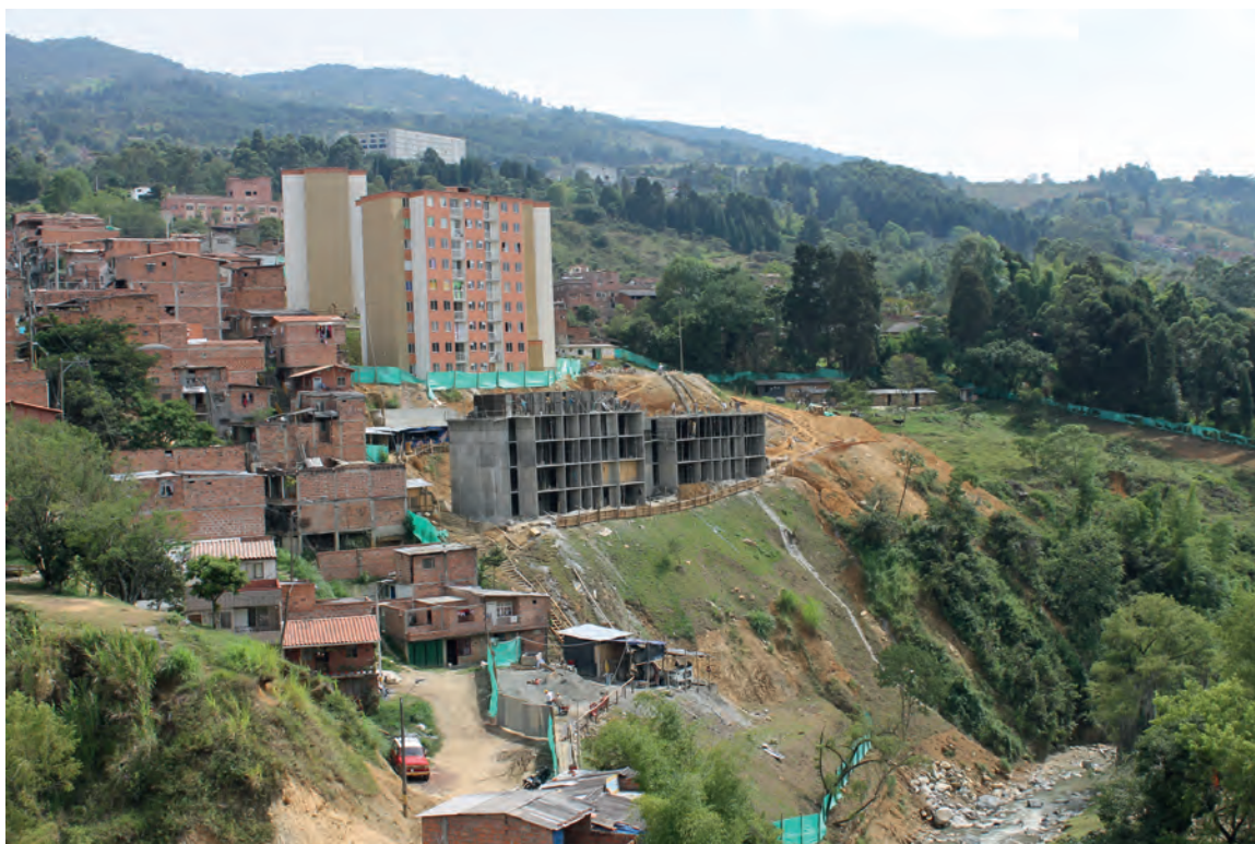
Edificaciones en riesgo geotécnico.
