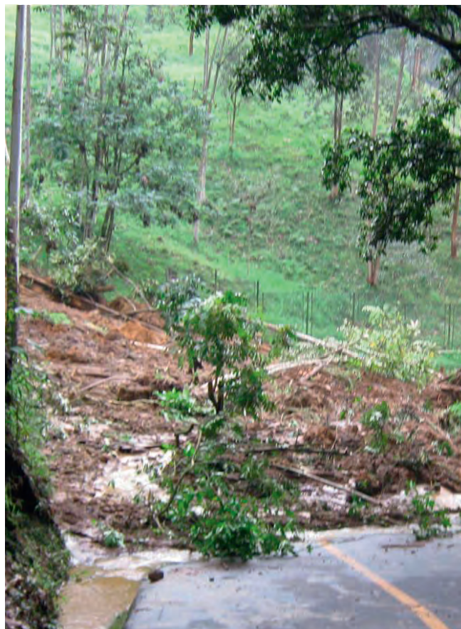
Deslizamiento sobre la vía.
