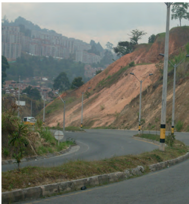
Taludes en intervención vial.
