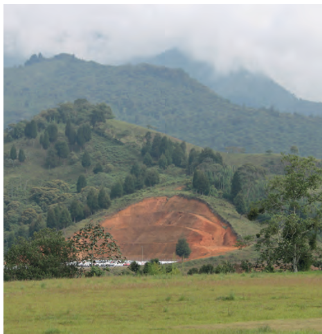
Escarpe en suelo residual.
