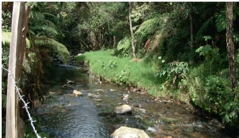
Cauce con potencial de desbordamiento.
