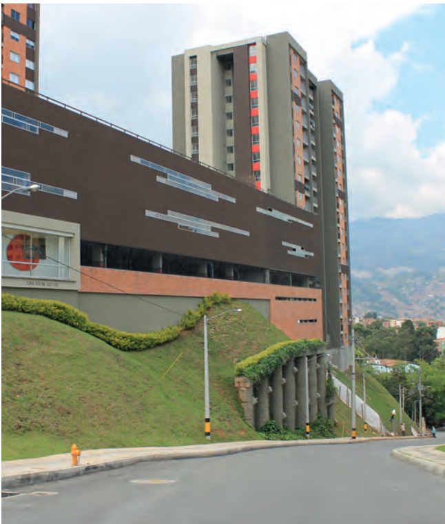
Sistema de contención.
