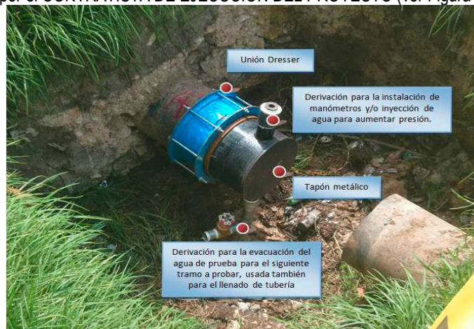
Figura 47. Esquema típico de Tapón de Prueba Hidráulica
