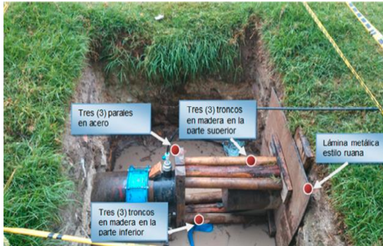
Figura 48. Ejemplo de anclaje temporal para Prueba CCP.
