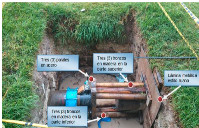
Figura 48. Ejemplo de anclaje temporal para Prueba CCP.
