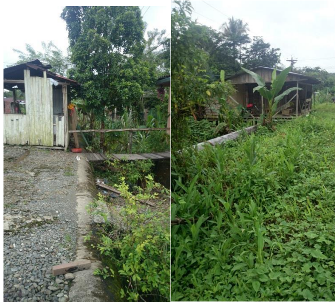
Figura 26. Tubería cercana a predios y Viaducto
