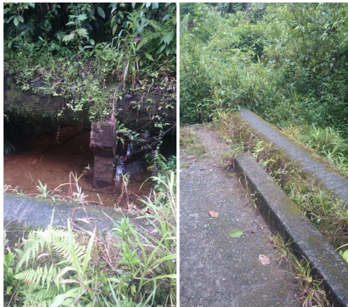
Figura 14 Paso sobre quebrada con apoyos en concreto
