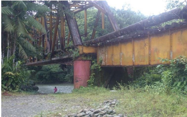
Figura 3. Cruce del Río Dagua, Puente Férreo.
