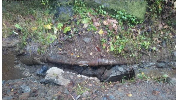
Figura 28. Aplastamiento de la red
