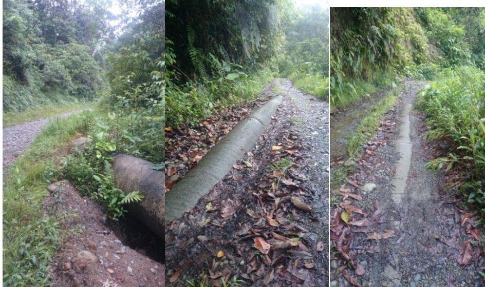
Figura 9. Tubería Visible, Semienterrada
