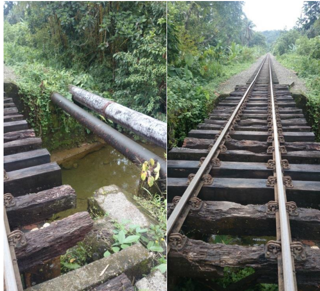
Figura 21. Paso sobre quebrada, paralela a vía férrea
