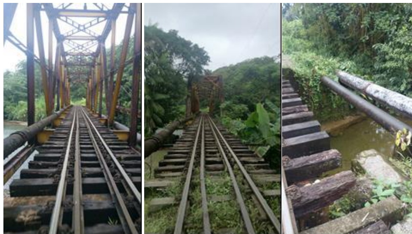
Figura 19. Viaducto Sin Tubería Instalada
