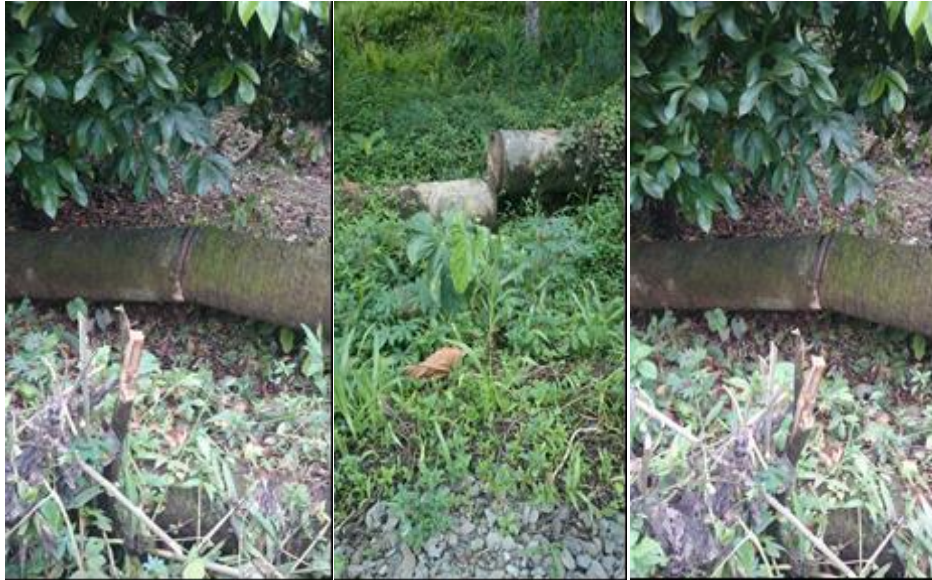
Figura 22. Tubería desempatada
