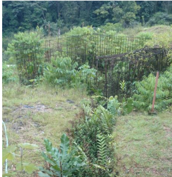
Figura 2. Tanque de Cloración sin terminar PTAP Escalerete
