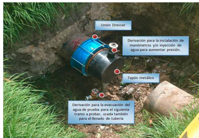
Figura 47. Esquema típico de Tapón de Prueba Hidráulica
