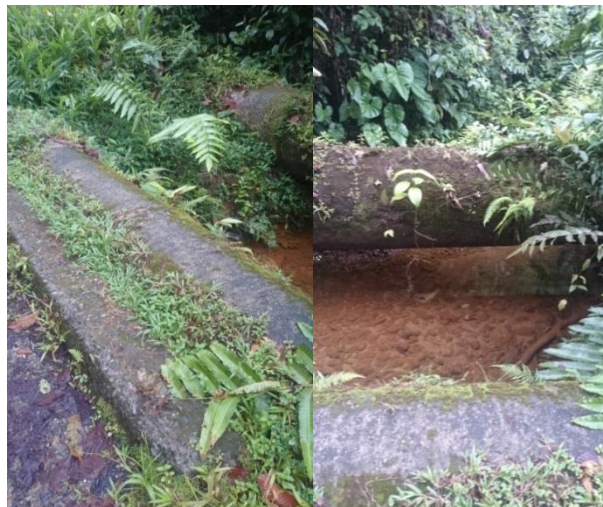
Figura 35. Paso sobre quebrada sin apoyos
