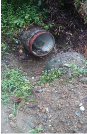
Figura 36. Desempate, accesorio no instalado
