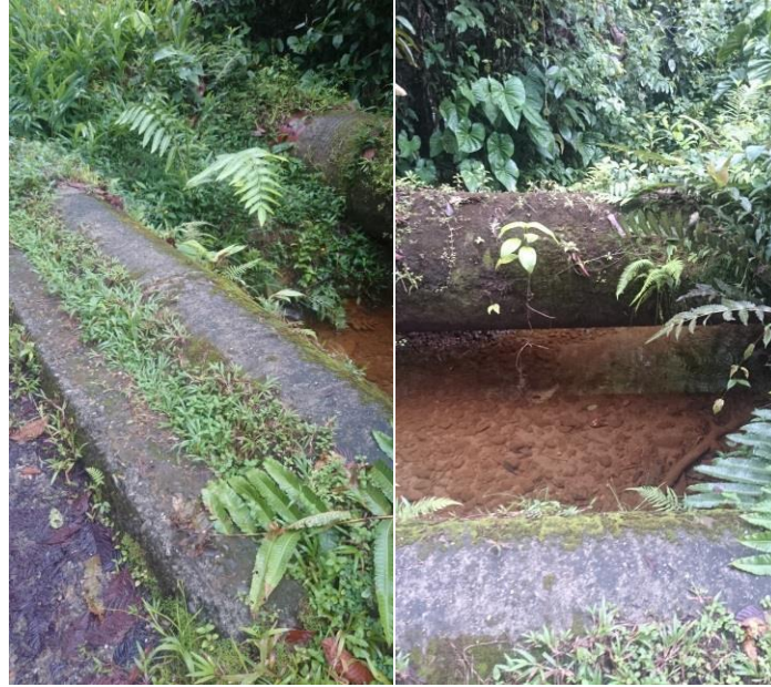
Figura 13. Paso sobre quebrada sin apoyos
