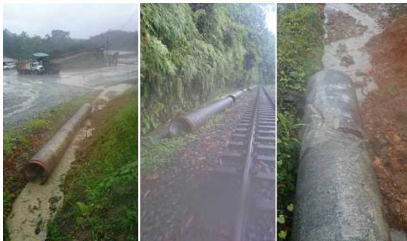
Figura 42. Tubería no instalada - Sector donde se localiza el macizo rocoso
