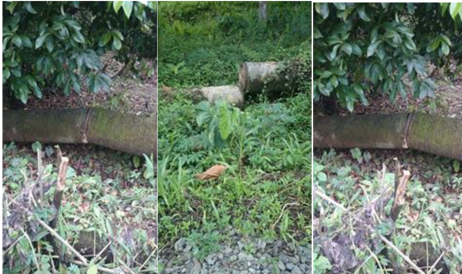
Figura 39. Tubería desempatada
