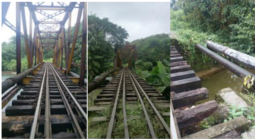
Figura 37. Viaducto Sin Tubería Instalada
