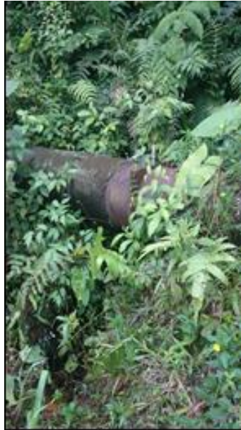
Figura 20. Tapón de Prueba - Tubería sobre terreno
