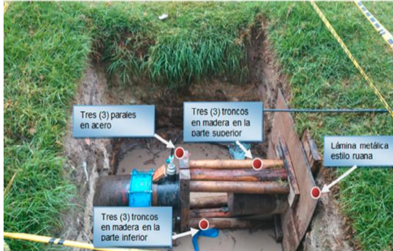
Figura 48. Ejemplo de anclaje temporal para Prueba CCP.
