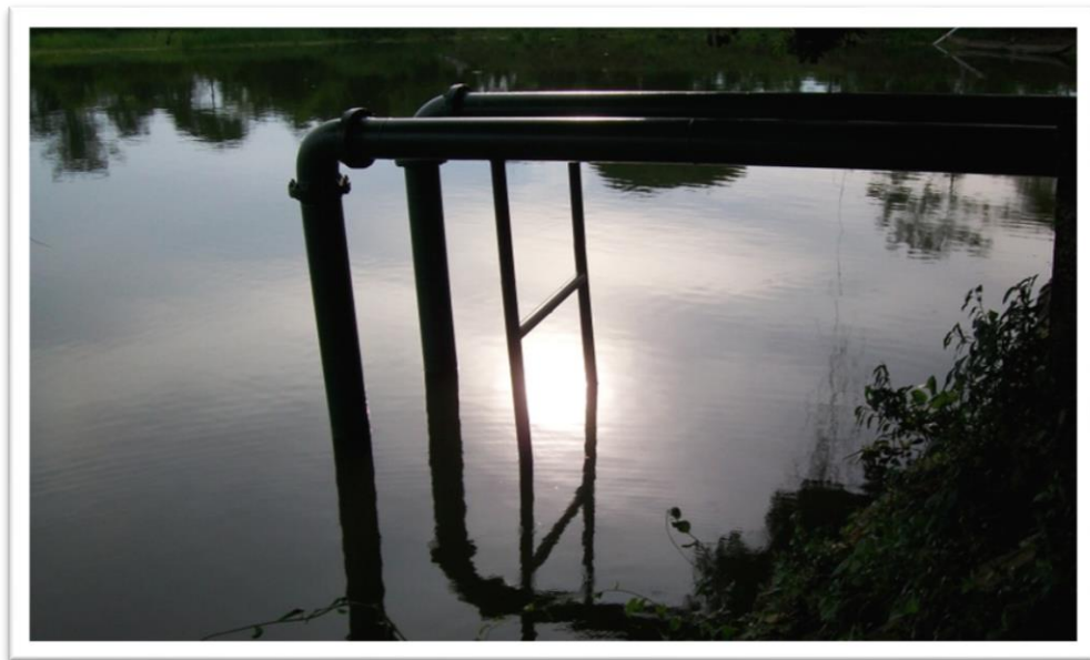
Figura N° 03 – Sitio de la succión, se observa el nivel de succión
