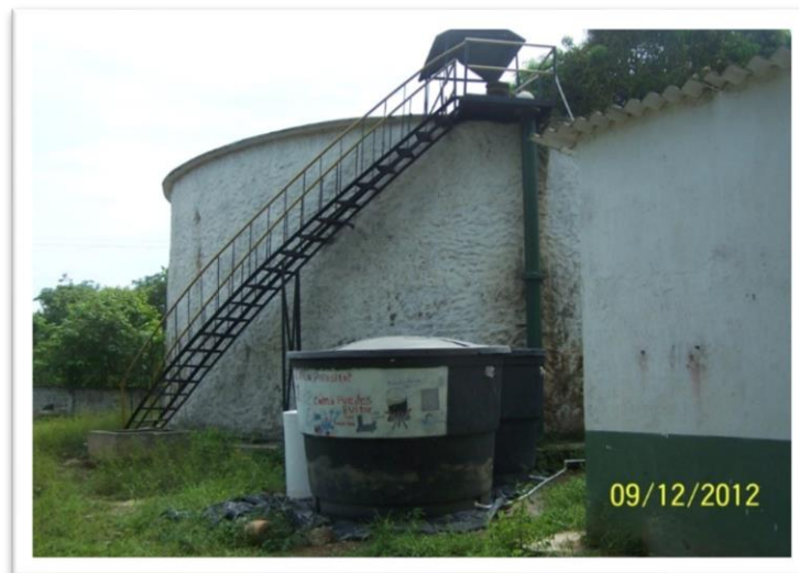
Figura N° 08 – Estado actual de la PTAP Compacta
