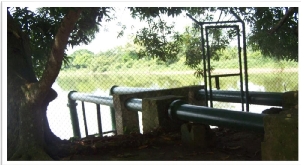
Figura N° 02 – Estado actual de la Bocatoma
