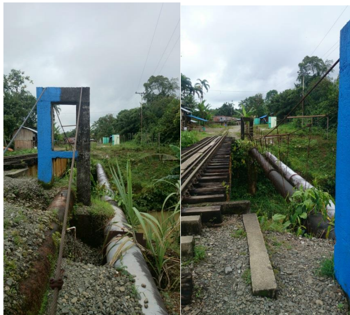
Figura 25. Tapón de prueba y Viaducto
