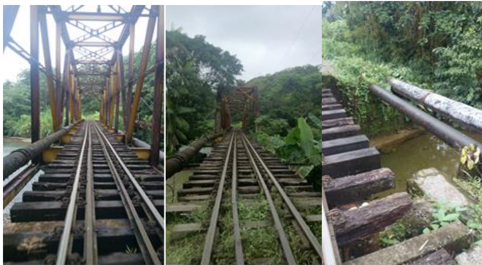
Figura 37. Viaducto Sin Tubería Instalada
