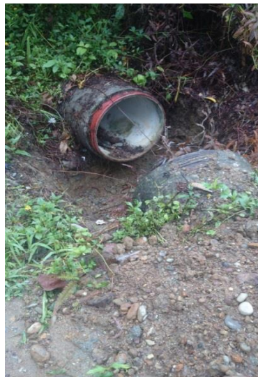
Figura 36. Desempate, accesorio no instalado
