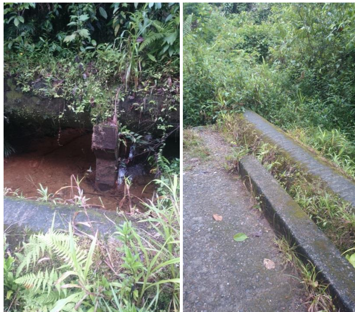
Figura 14 Paso sobre quebrada con apoyos en concreto
