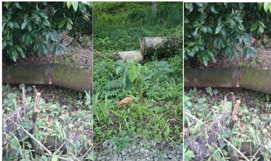
Figura 39. Tubería desempatada
