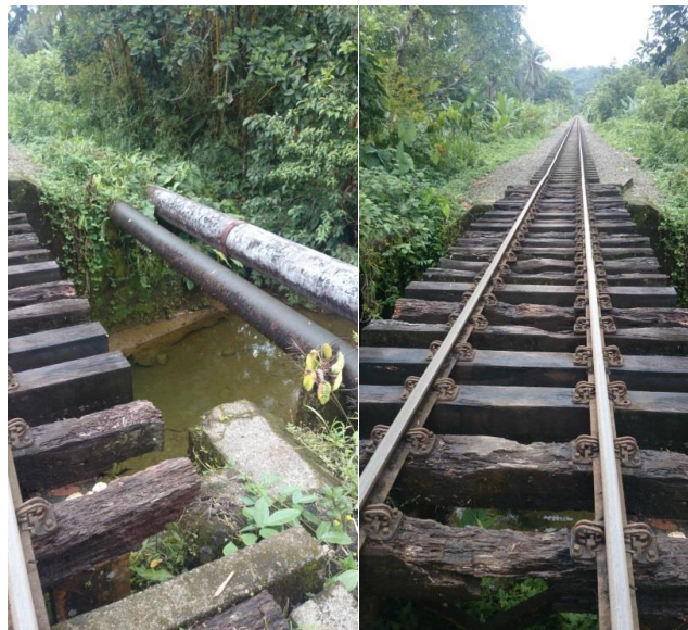
Figura 21. Paso sobre quebrada, paralela a vía férrea
