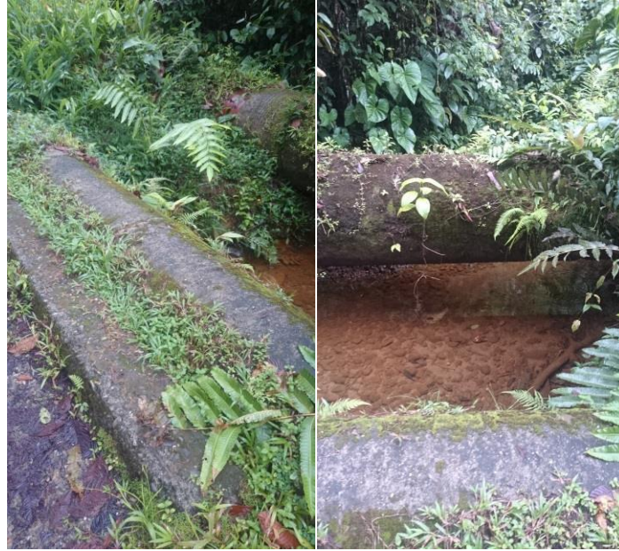
Figura 13. Paso sobre quebrada sin apoyos
