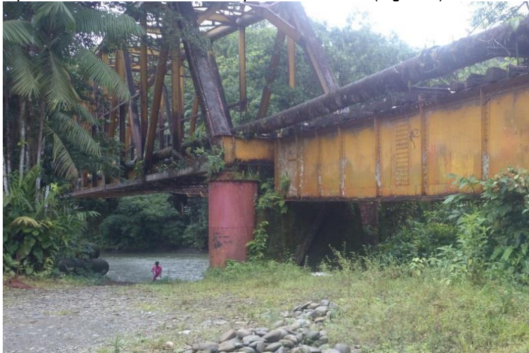
Figura 3. Cruce del Rio Dagua, Puente Férreo.
