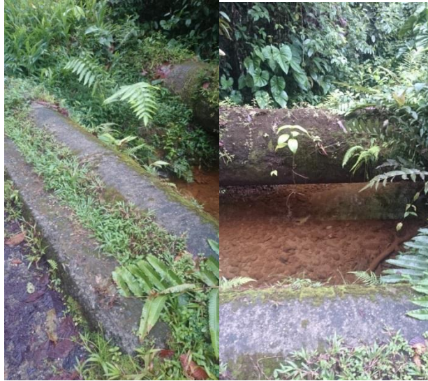
Figura 35. Paso sobre quebrada sin apoyos
