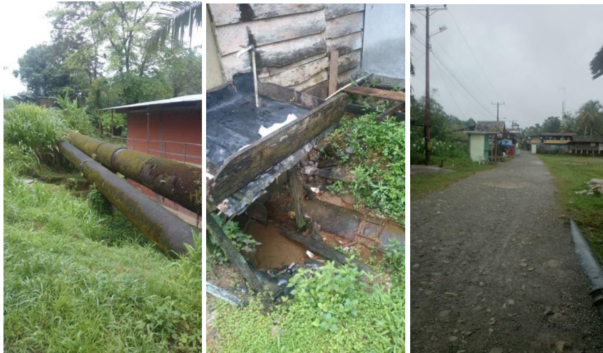
Figura 14. Tubería cercana a predios
