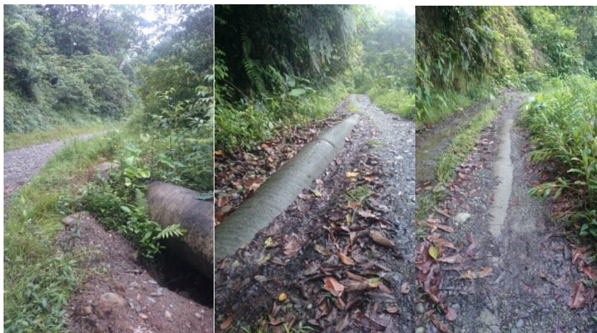
Figura 32. Tubería Visible, Semienterrada
