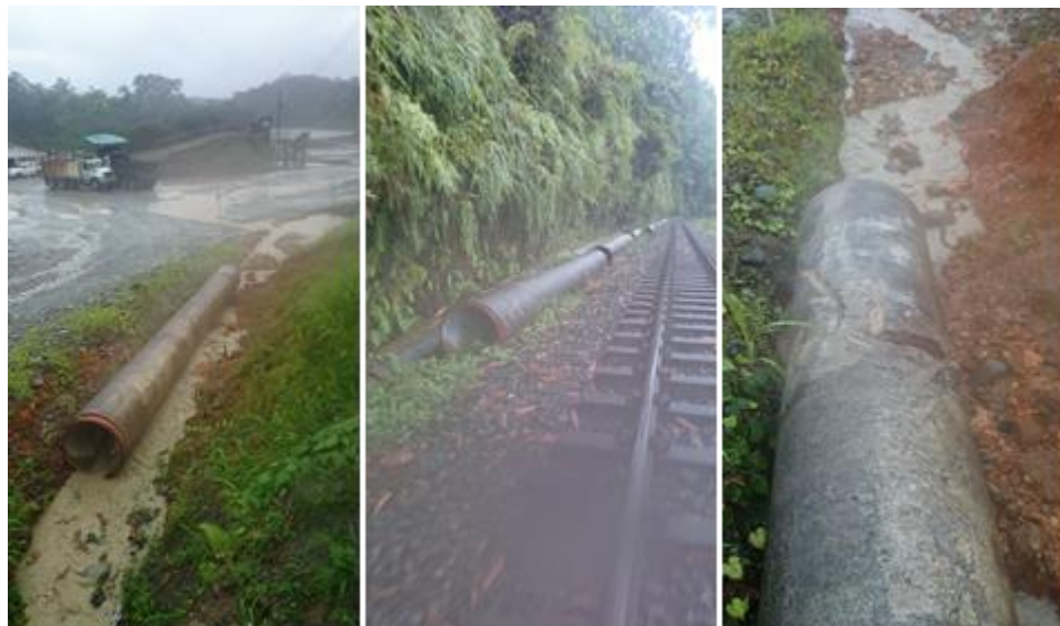
Figura 42. Tubería no instalada - Sector donde se localiza el macizo rocoso
