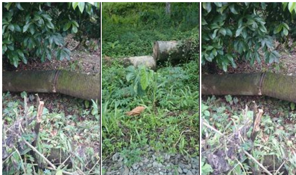
Figura 22. Tubería desempatada
