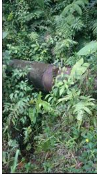
Figura 20. Tapón de Prueba - Tubería sobre terreno
