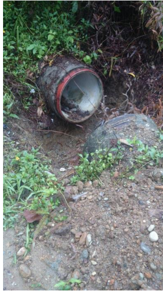
Figura 15. Desempate, accesorio no instalado
