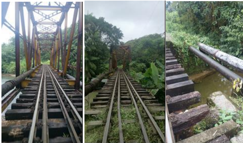
Figura 19. Viaducto Sin Tubería Instalada
