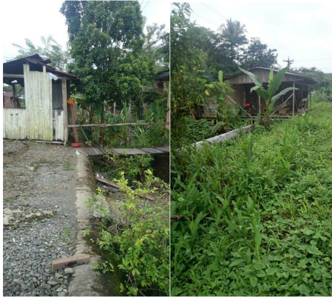
Figura 26. Tubería cercana a predios y Viaducto
