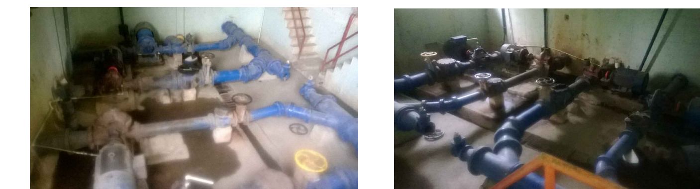
FOTOGRAFÍAS MOSTRANDO EL ACTUAL ESTADO DE LA ESTACIÓN DE BOMBEO
