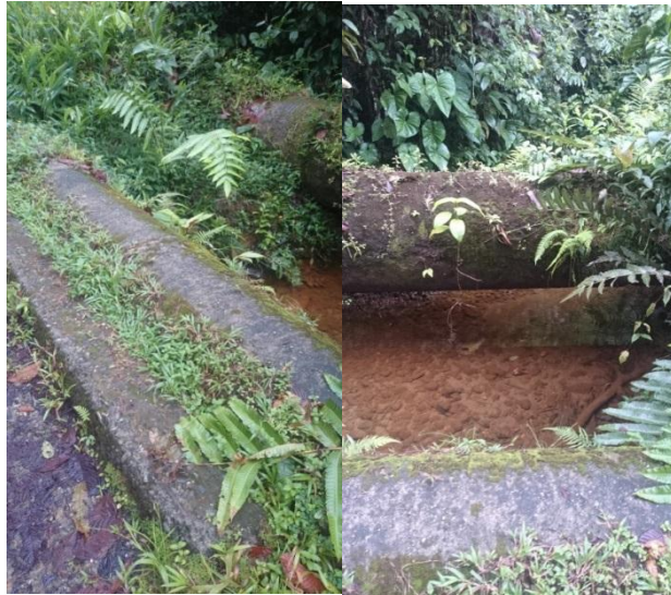
Figura 6. Paso sobre quebrada sin apoyos
