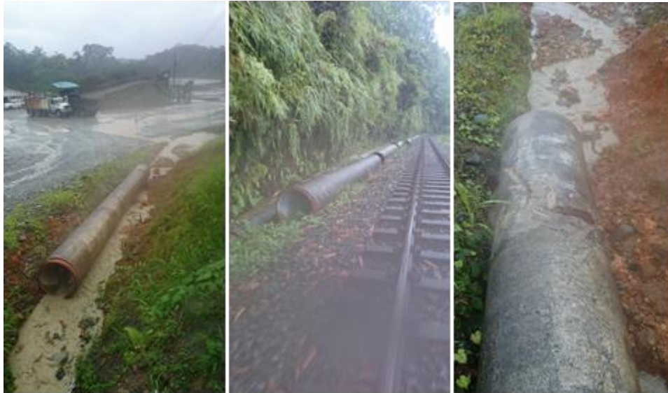
Figura 13. Tubería no instalada - Sector donde se localiza el macizo rocoso
