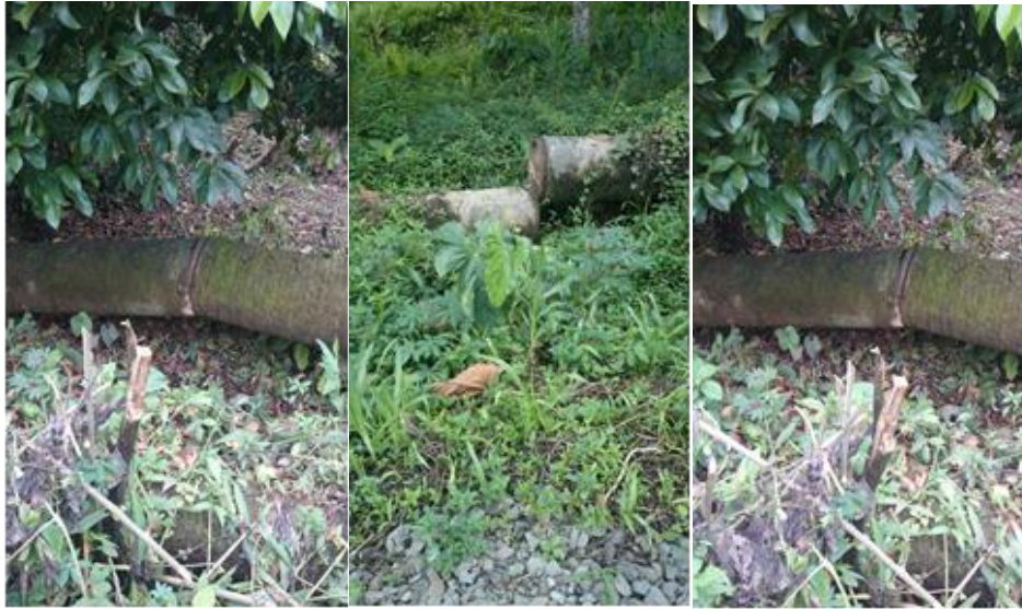
Figura 10. Tubería desempatada
