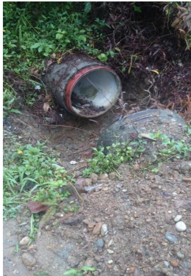
Figura 7. Desempate, accesorio no instalado
