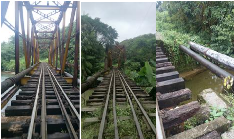
Figura 8. Viaducto Sin Tubería Instalada
