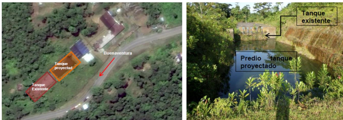
Ilustración No. 5 – Vista general tanque existente y localización tanque proyectado (PTAP Venecia)
