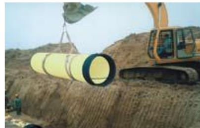
Teniendo en cuenta el peso de la Tubería y la disponibilidad en obra de maquinaria y personal, el descargue se puede hacer manualmente o usando
