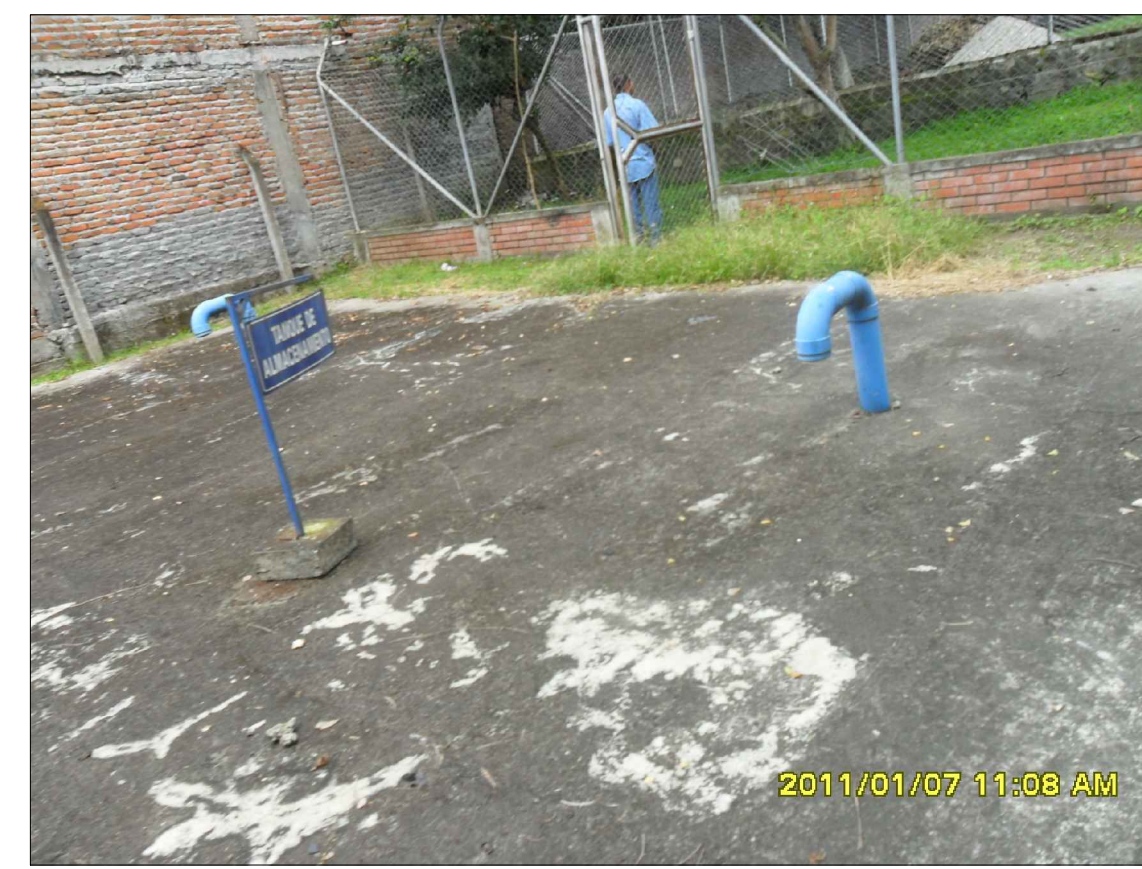
VISTA TANQUE COLSEGUROS
