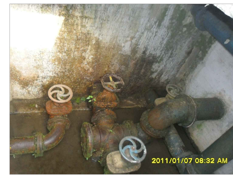
VISTA CAJA REPARTICION
