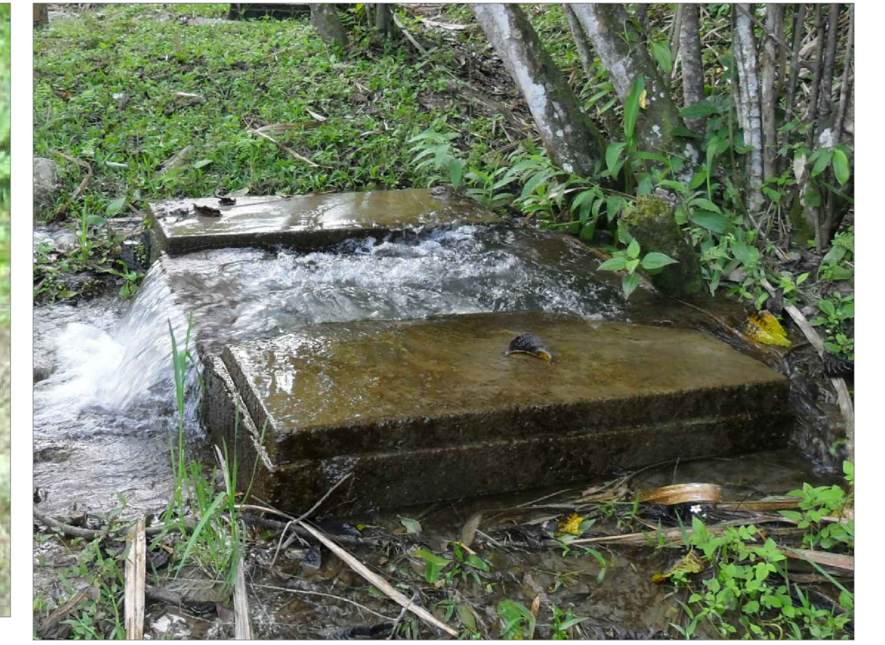
VISTA TÍPICA CÁMARA DE LIMPIEZA (ADUCCIÓN)
