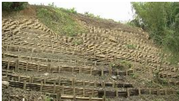
Foto 1-3 Barreras por medio de trinchos y cortacorrientes
