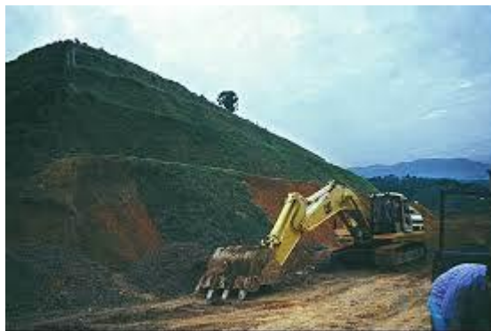
Foto 1-4 conformación de taludes
