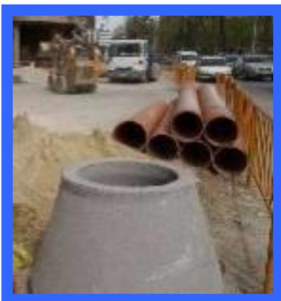
Es la sección superior del pozo de inspección construido en concreto. Incluye los ganchos para los pasos, en hierro de diámetro 3/4" cada 0.30 m, debidamente pintados con dos capas de pintura anticorrosiva y dos de acabado epóxica.
