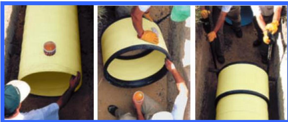
El espigo se introduce dentro de la campana hasta que haya contacto con el anillo de caucho. Hay que mantener el alineamiento de los tramos de tubería. La campana se debe sujetar bien mientras penetra el espigo de forma tal que las uniones que ya se han efectuado no se cierren. Empujar hasta que la marca de referencia esté al haz de la campana. La tubería se puede ensamblar a mano, o con una barra y un bloque haciendo palanca. Nunca se debe golpear la tubería al ensamblarla.
