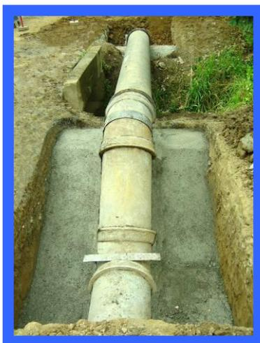
Se debe tener en cuenta la presión hidrostática, diámetro, clase de la tubería, clase de terreno y tipo de accesorios.
