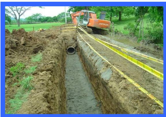
Los materiales comúnmente usados para cimentar tuberías de acueducto y alcantarillado con el objeto de aumentar el factor de carga de las tuberías y para evitar asentamientos y desplazamientos de las mismas, son de las siguientes clases: concreto, arena limpia, material granular, material seleccionado, rebase arenoso y piedra partida. Estos materiales deben cumplir las especificaciones generales dadas anteriormente y las que se dan a continuación para cada tipo especial.
