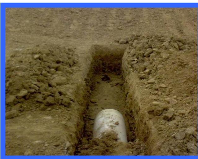
En terrenos de buena calidad el fondo puede ser el mismo del terreno, en cambio en aquellos de malas características, el Interventor indica el tipo de cimentación adecuado, según el caso. Para este evento la zanja debe excavarse por lo menos 10 cm por debajo de la cota establecida con base en la parte exterior de la tubería o más según la indicación de la Interventoría. Esta excavación adicional se rellena con
