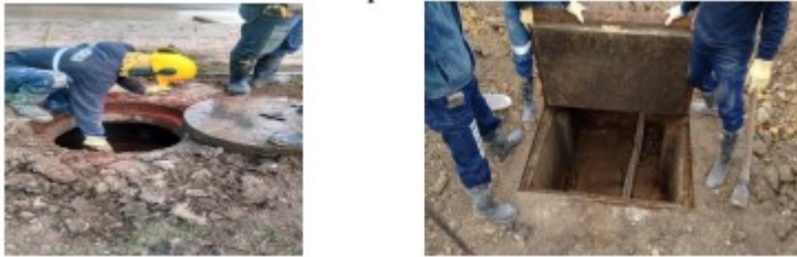
Ilustración 6. Inspección de Servicios
