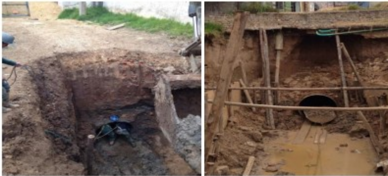
Ilustración 23. Limpieza Manual del Pipe Ramming
