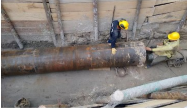
Ilustración 18. Acople de Equipo con Camisa de Acero
