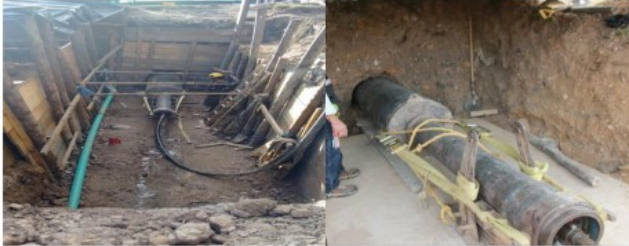
Ilustración 22. Instalación de Equipo Ramming
