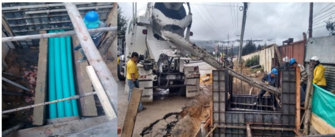
Ilustración 27. Fabricación de Pozos de Acceso para Tubería Instalada
