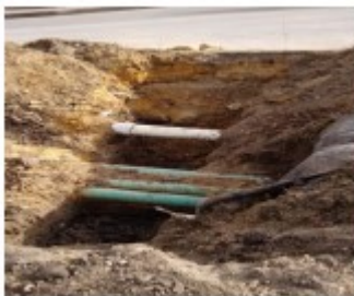
Ilustración 7. Apique para Inspección de Servicios
