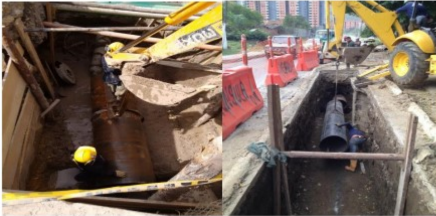
Ilustración 21. Proceso de Ubicación Camisa de Acero
