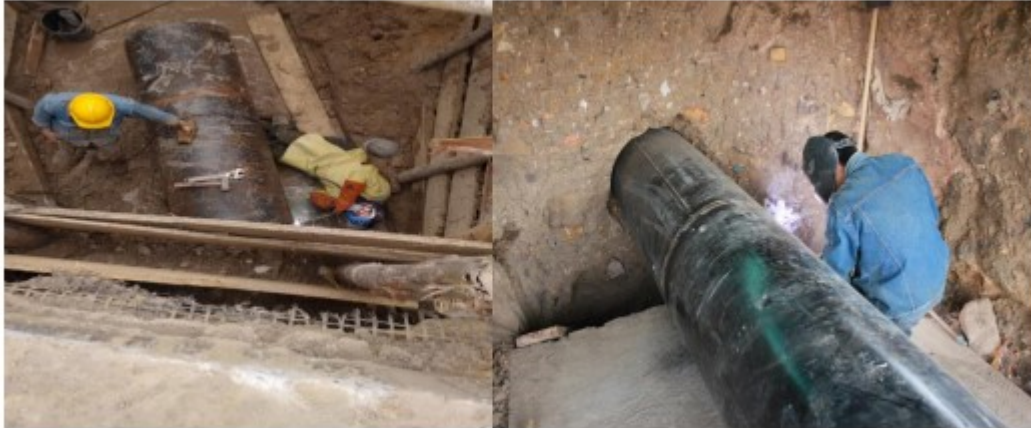
Ilustración 24. Proceso Soldadura de Camisa de Acero
