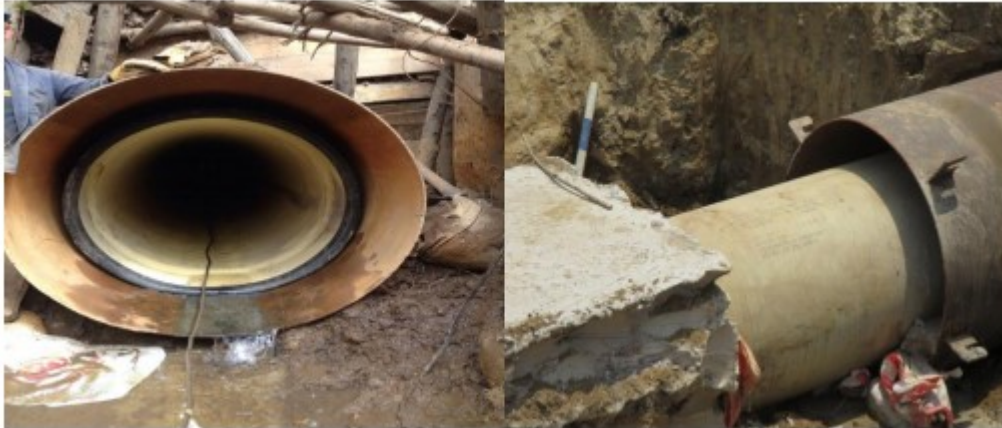
Ilustración 26. Instalación de Tubería Dentro de Camisa de Acero
