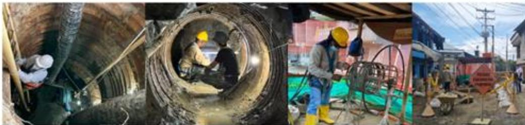
Construcción a zanja abierta y túnel liner para mejorar y ampliar el sistema de alcantarillado de Quibdó, Chocó. Fase I. Inversión \$10.706 millones. [En ejecución](#)
