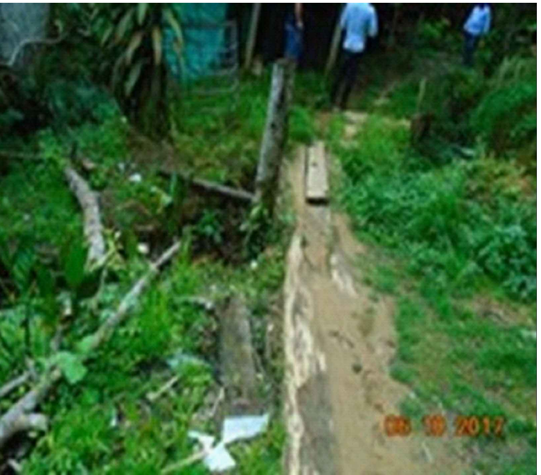
PASO SUBFLUVIAL 54 REGISTRO FOTOGRAFICO
