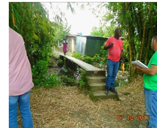
VIADUCTO 84 L=12.00m registro fotográfico
