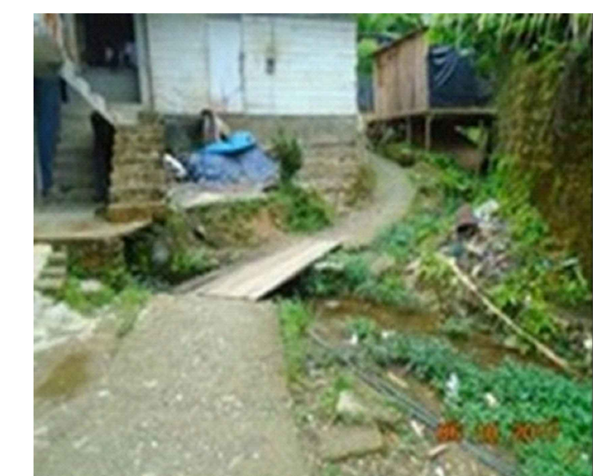
PASO SUBFLUVAL 48 REGISTRO FOTOGRAFICO
