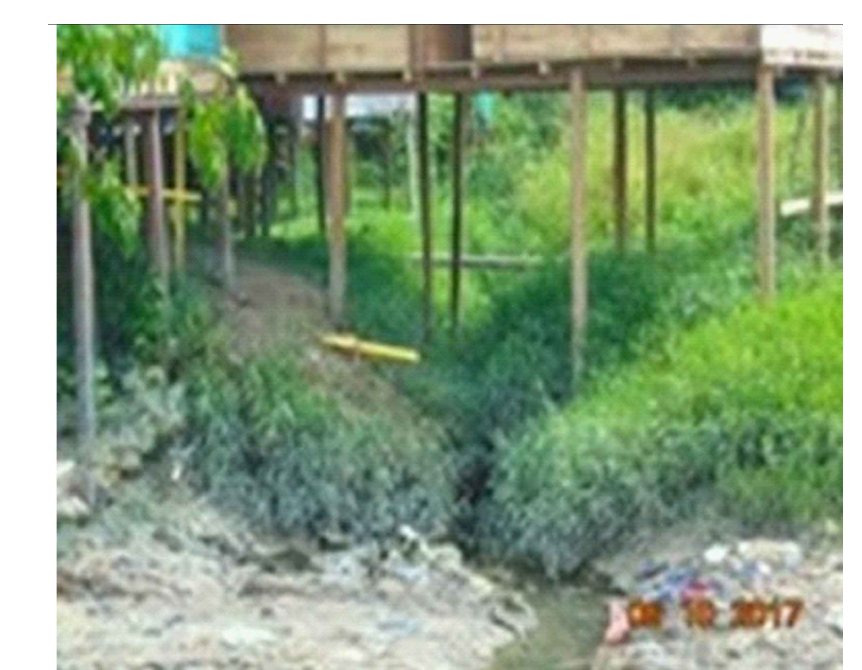
PASO SUBFLUVAL 37 REGISTRO FOTOGRAFICO
