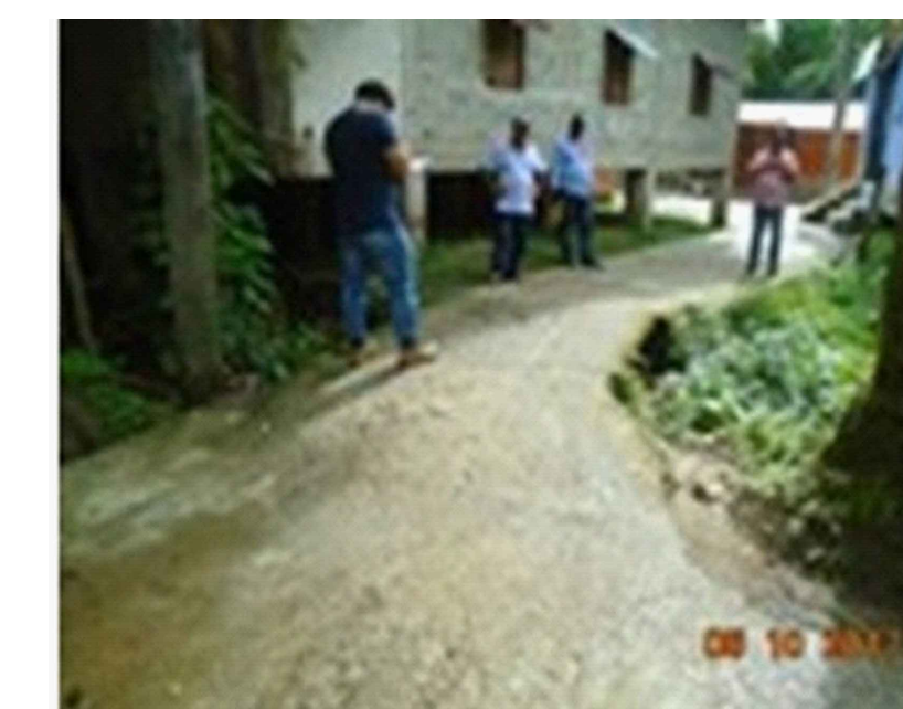
PASO SUBFLUVAL 33 REGISTRO FOTOGRAFICO
