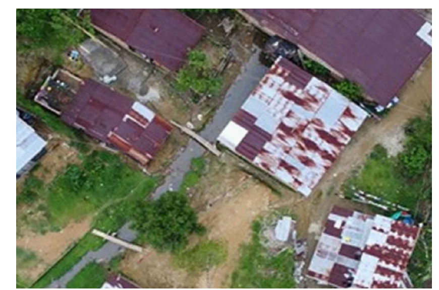
PASO SUBFLUVIAL 20 REGISTRO FOTOGRAFICO
