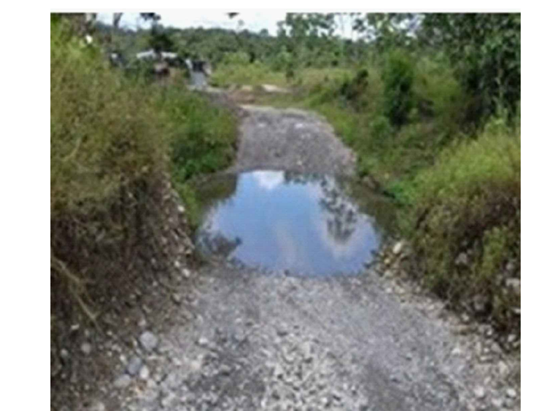
PASO SUBFLUVIAL 108 REGISTRO FOTOGRAFICO
