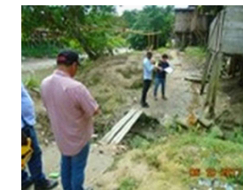
PASO SUBFLUVAL 36 REGISTRO FOTOGRAFICO
