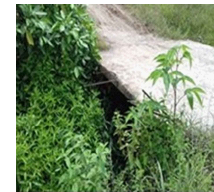
PASO SUBFLUVIAL 106 REGISTRO FOTOGRAFICO
