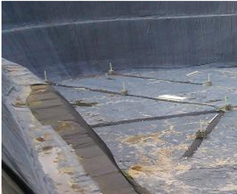
Foto 2.1 Red de drenaje de biogás y ubicación de gaviones
