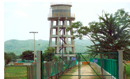
TANQUE ELEVADO DE PENDALES Volumen almacenamiento 240M3
