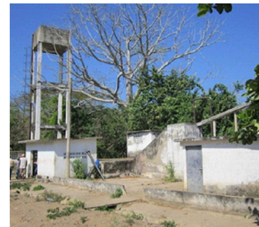
TANQUE ELEVADO Y ESTACION DE BOMBEO SAN JUAN DE TOCAGUA
