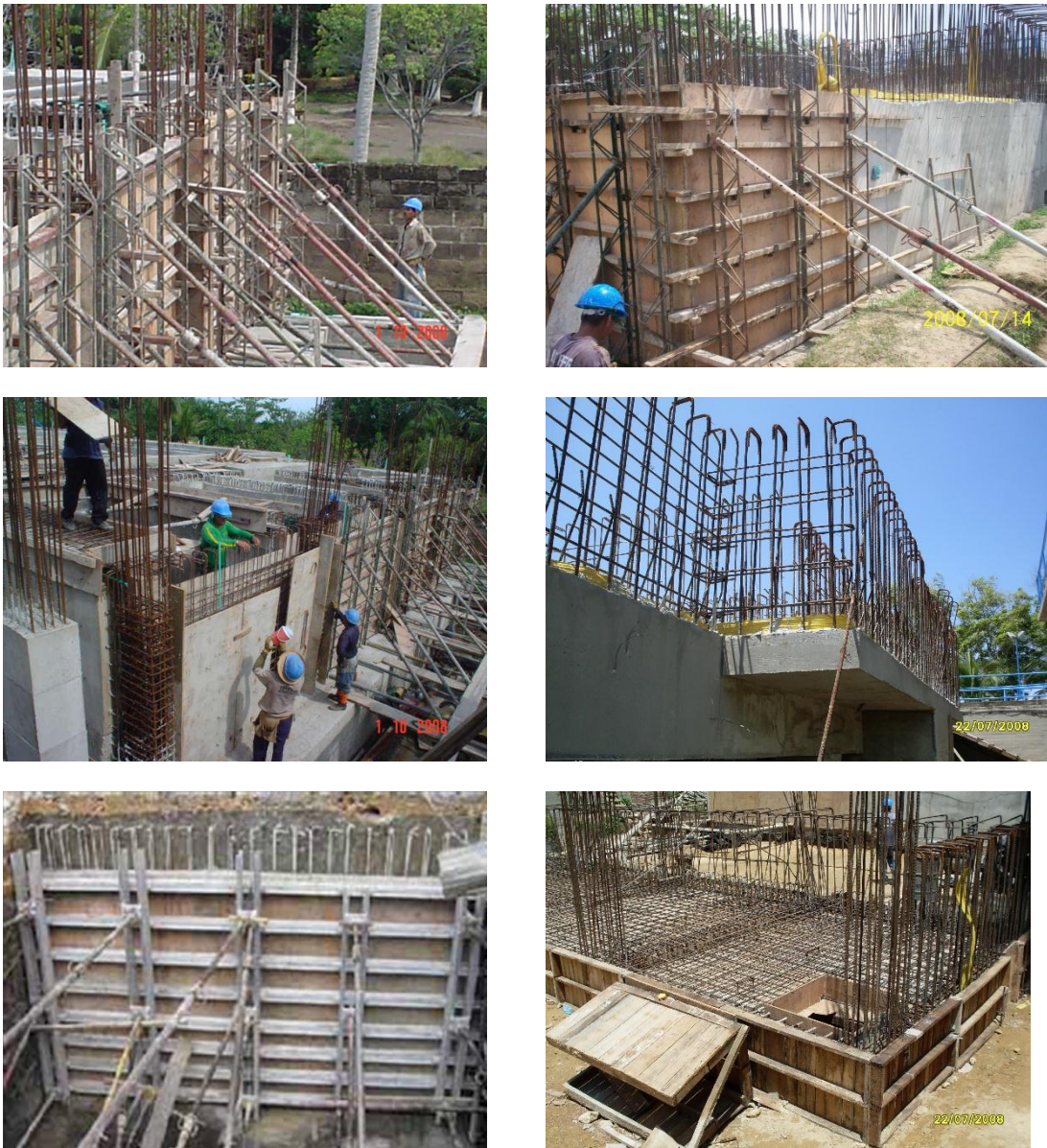
FIG. 3.7.3.1. FORMALETA ACABADO A LA VISTA
