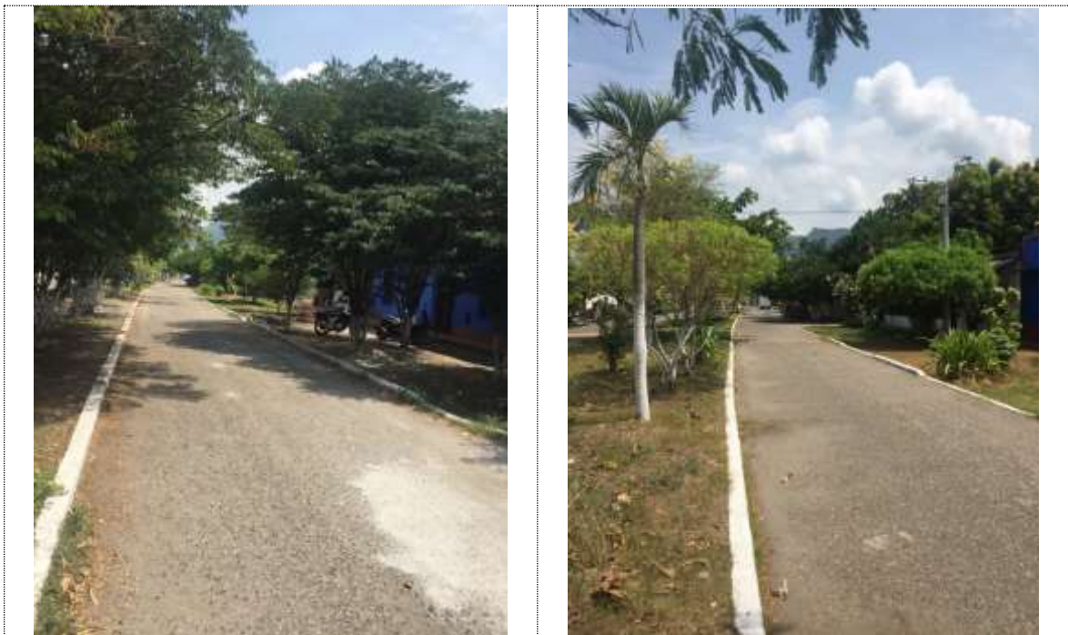
Figura 9: Se observa el corredor por donde se encuentra instalada la red sanitaria con problemas de obstrucción reiterada por fallos de la tubería.
