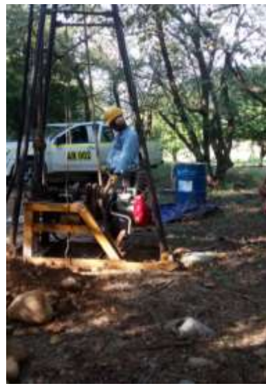
Ejecución sondeo con equipo rotopercutor
