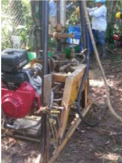
Ejecución sondeo con equipo rotopercutor
