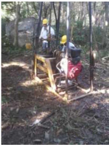
Ejecución sondeo con equipo rotopercutor
