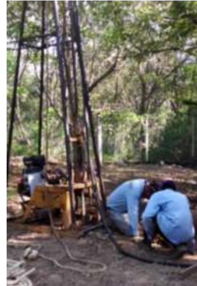
Ejecución sondeo con equipo rotopercutor
