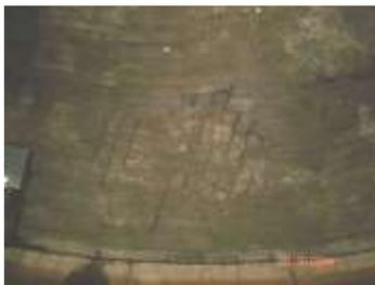
**Fotografía No. 4.** Refuerzo expuesto en cúpulas de concreto de tanques circulares en concreto.
