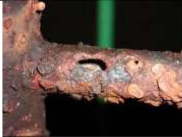
**Fotografía No. 5.** Detalle de una perforación causada por corrosión en uno de los peldaños de la escalera de acceso al tanque (acero galvanizado pintado). Enero 2003.1
