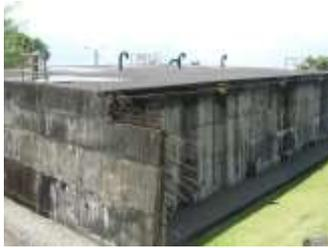
**Fotografía No. 1.** Tanque en concreto Áurea 1. Obsérvese las juntas frías en los muros del tanque.
