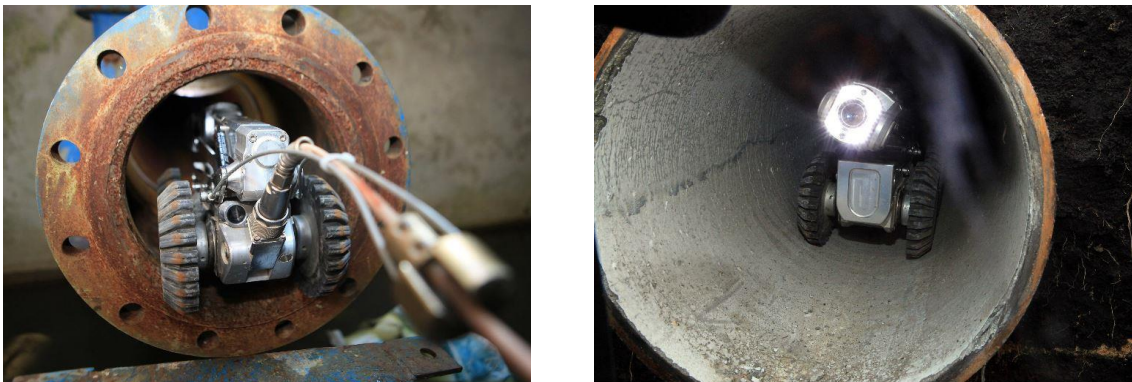
Figura 46. Equipo de Inspección Visual Interna (fuente: EPC)
