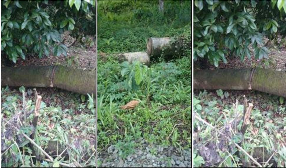
**Figura 22. Tubería desempatada**
