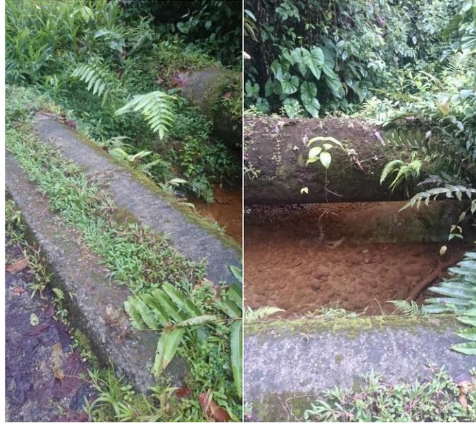
**Figura 13. Paso sobre quebrada sin apoyos**
