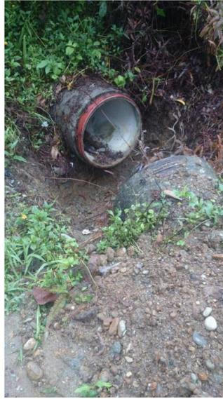
**Figura 15. Desempate, accesorio no instalado**
