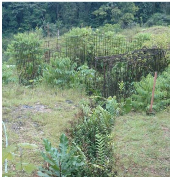
**Figura 2. Tanque de Cloración sin terminar PTAP Escalerete**
