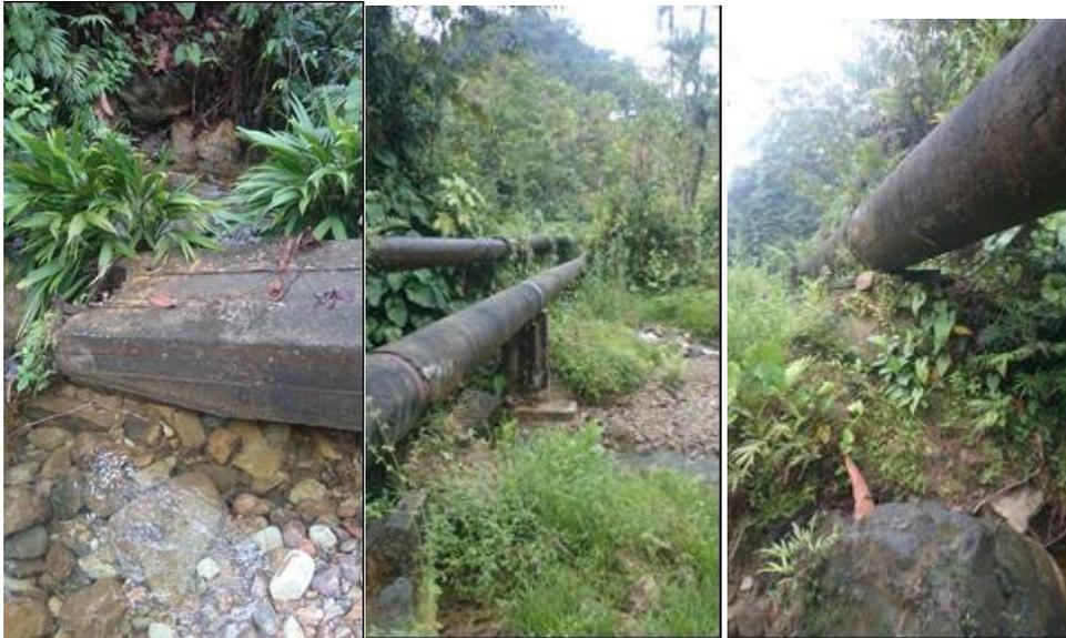
**Figura 7. Paso elevado en mal estado.**
