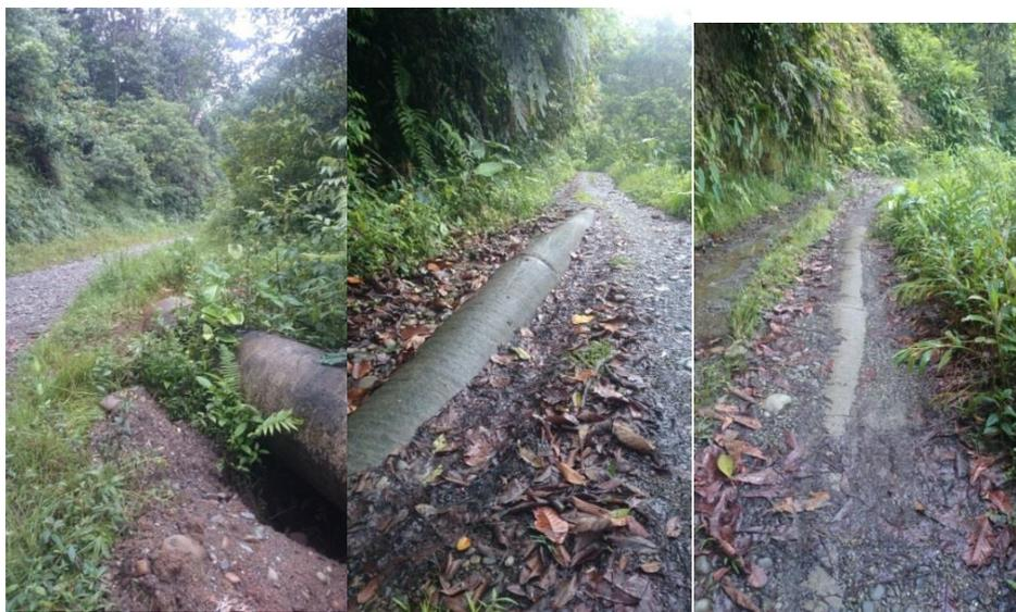
**Figura 9. Tubería Visible, Semienterrada**
