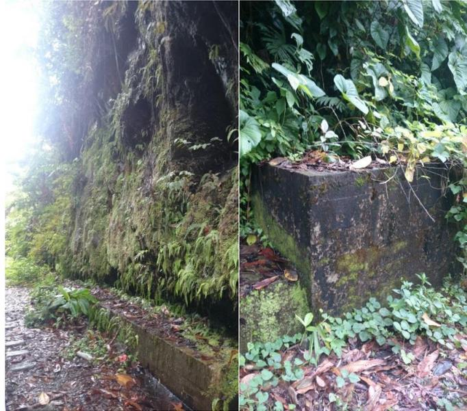
**Figura 24. Tubería protegida por cárcamo en concreto**
