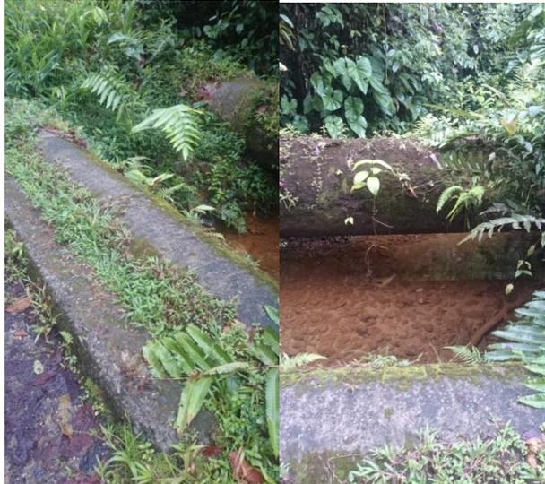
**Figura 35. Paso sobre quebrada sin apoyos**
