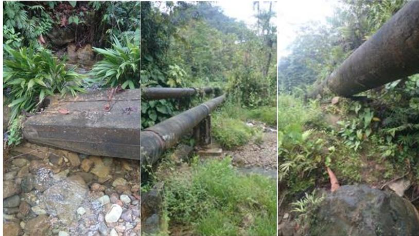
**Figura 31. Paso elevado en mal estado**
