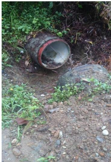
**Figura 36. Desempate, accesorio no instalado**
