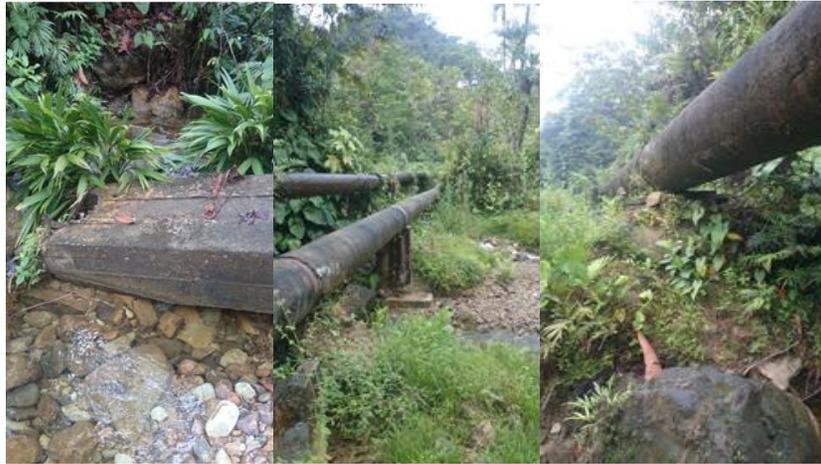
**Figura 2. Paso elevado en mal estado**
