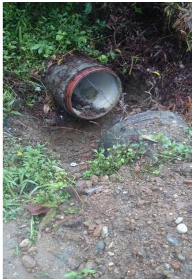
**Figura 7. Desempate, accesorio no instalado**
