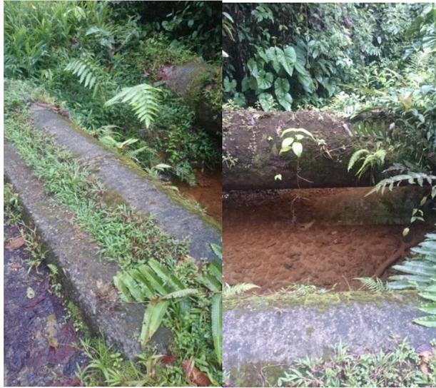
**Figura 6. Paso sobre quebrada sin apoyos**
