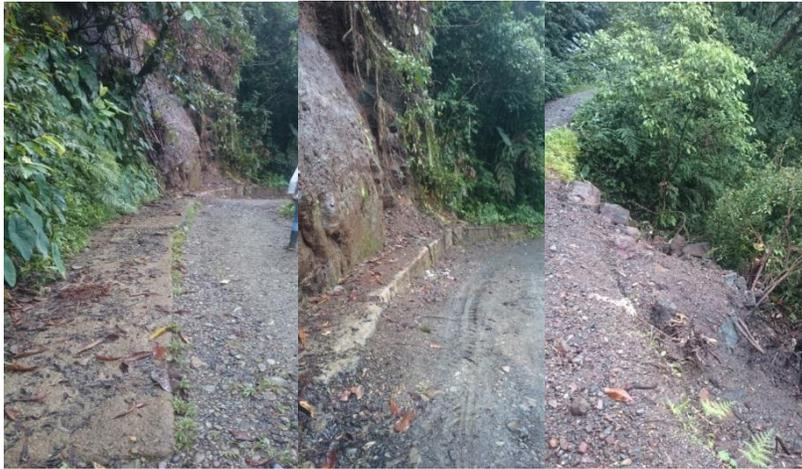
**Figura 4. Deslizamiento sobre cárcamo**
