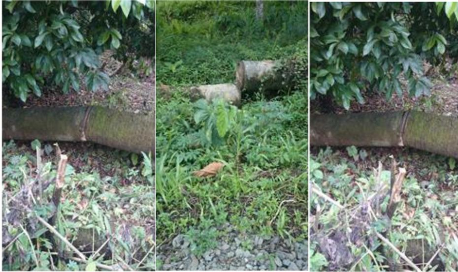
**Figura 10. Tubería desempatada**
