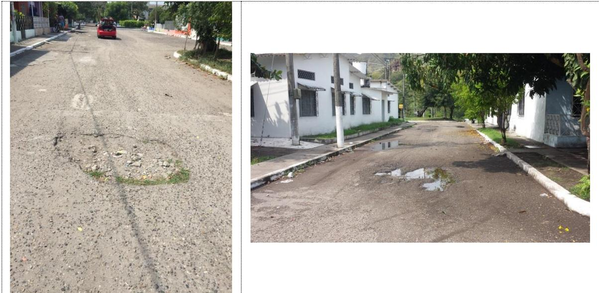
Figura 7: Daños causados por alcantarillado barrio Refugio
