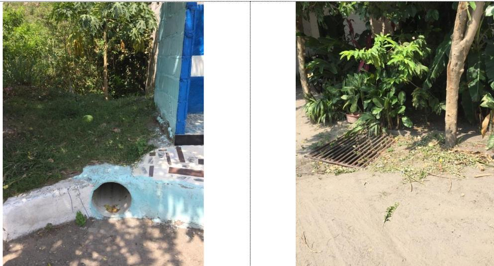
*Figura 11:* Se puede observar diferentes soluciones que se han dado en el lugar para poder evacuar las aguas lluvias y reducir el impacto en las zonas centrales del sector Ambalemita.
