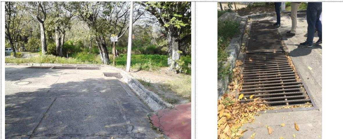
Figura 3: Sumidero alcantarillado pluvial Chico Alto
