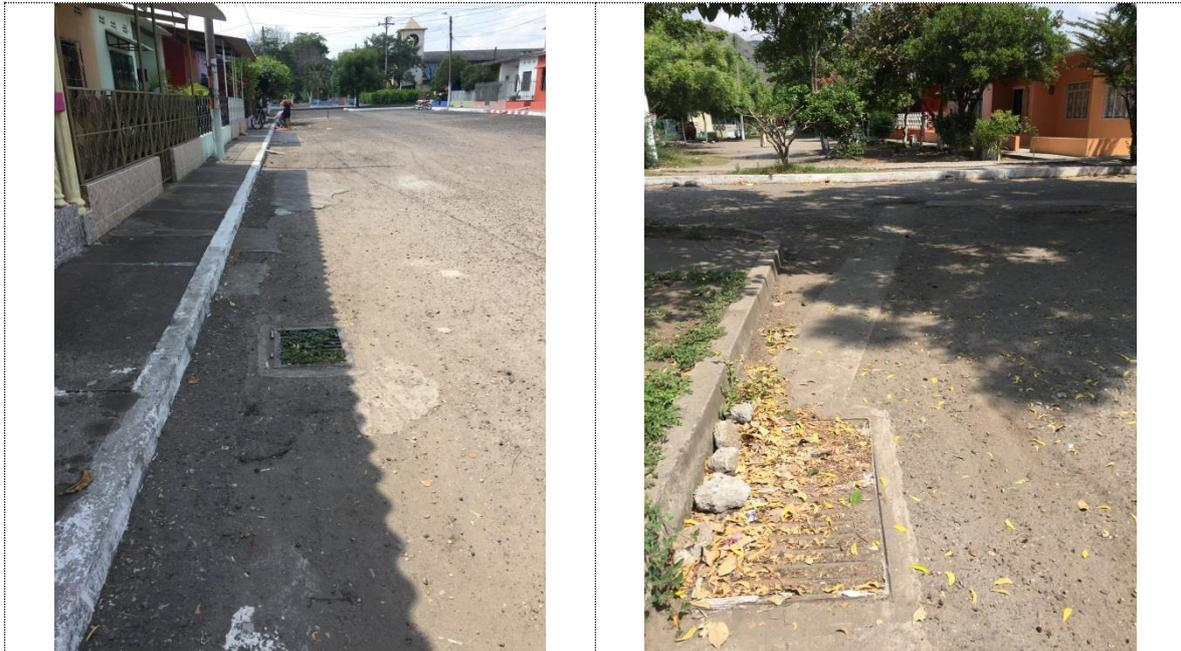
Figura 8: Sumideros construidos y conectados al sistema sanitario original
