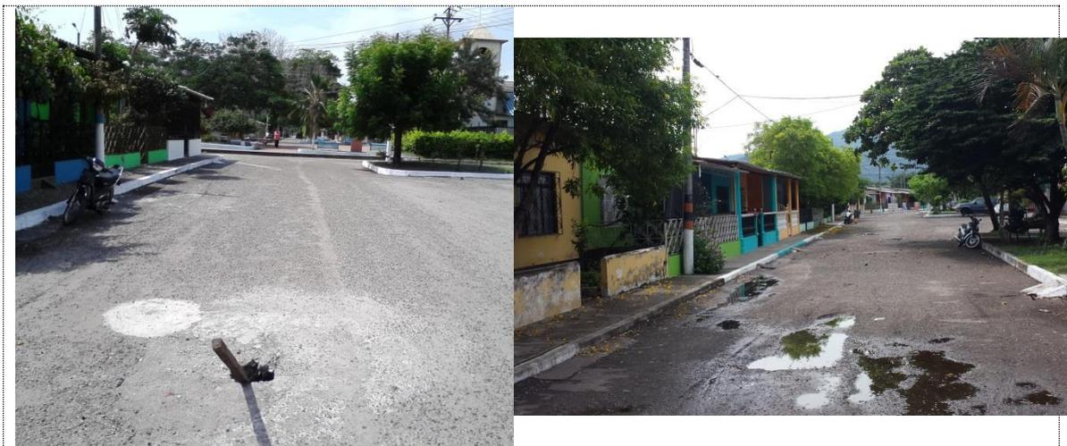
Figura 1 Colapso tubería de alcantarillado Barrio Refugio
