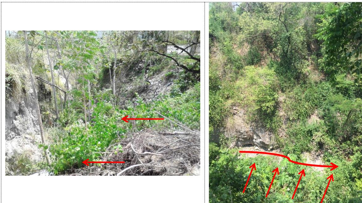
Figura 4: Carvacava producida por descarga de aguas lluvias barrio Chico
