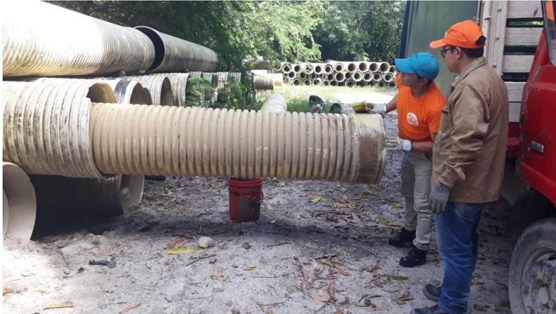
Tubería en Policloruro de Vinilo (PVC) Alcantarillado Doble Pared con una pared interior de características lisas y una exterior corrugada. Sistema de Unión mecánica. Tubo con extremo acampanado mediante sistema de hidrosello y el otro extremo con espigo.
