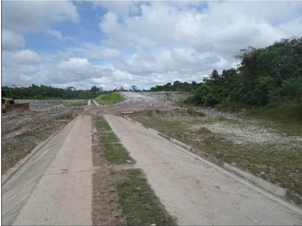
Foto 3. Vía interna en placa huella.
