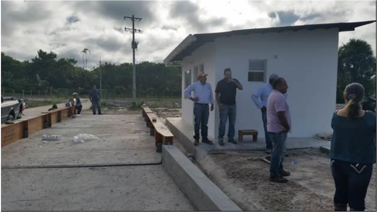
Foto 1. Báscula y caseta de entrada construidas.
