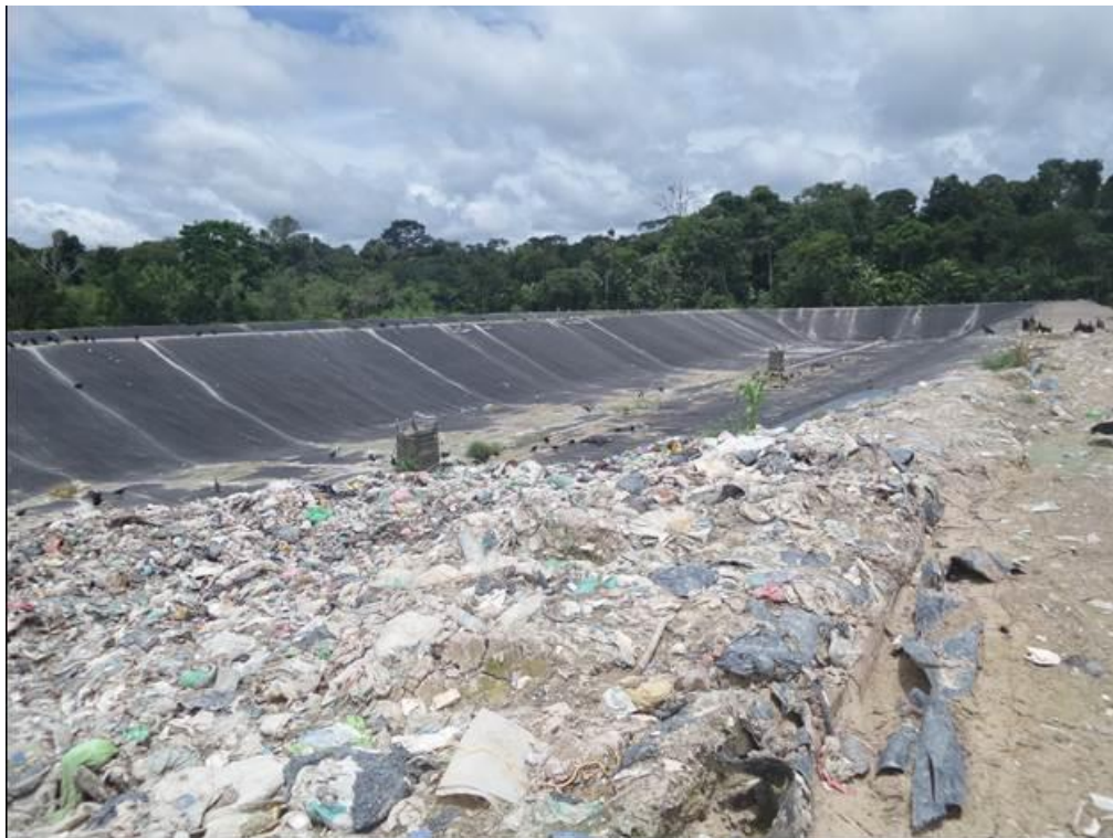
Foto 6. Zona sin cobertura de residuos en T5
