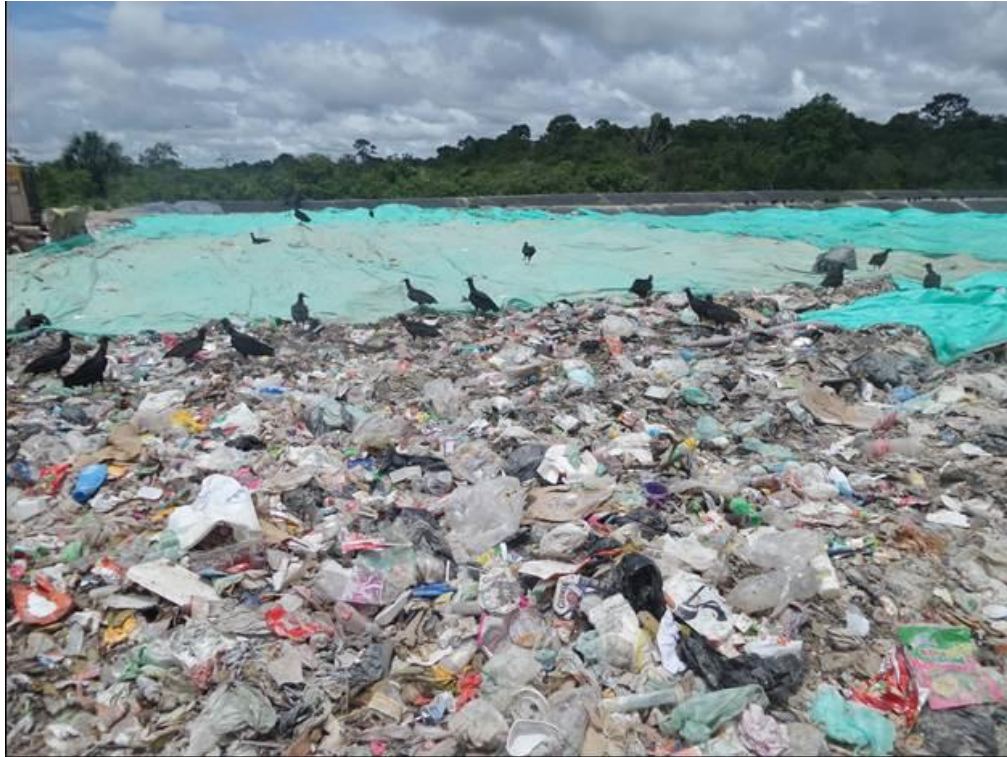
Foto 5. Cobertura parcial residuos trinchera 5 en operación
