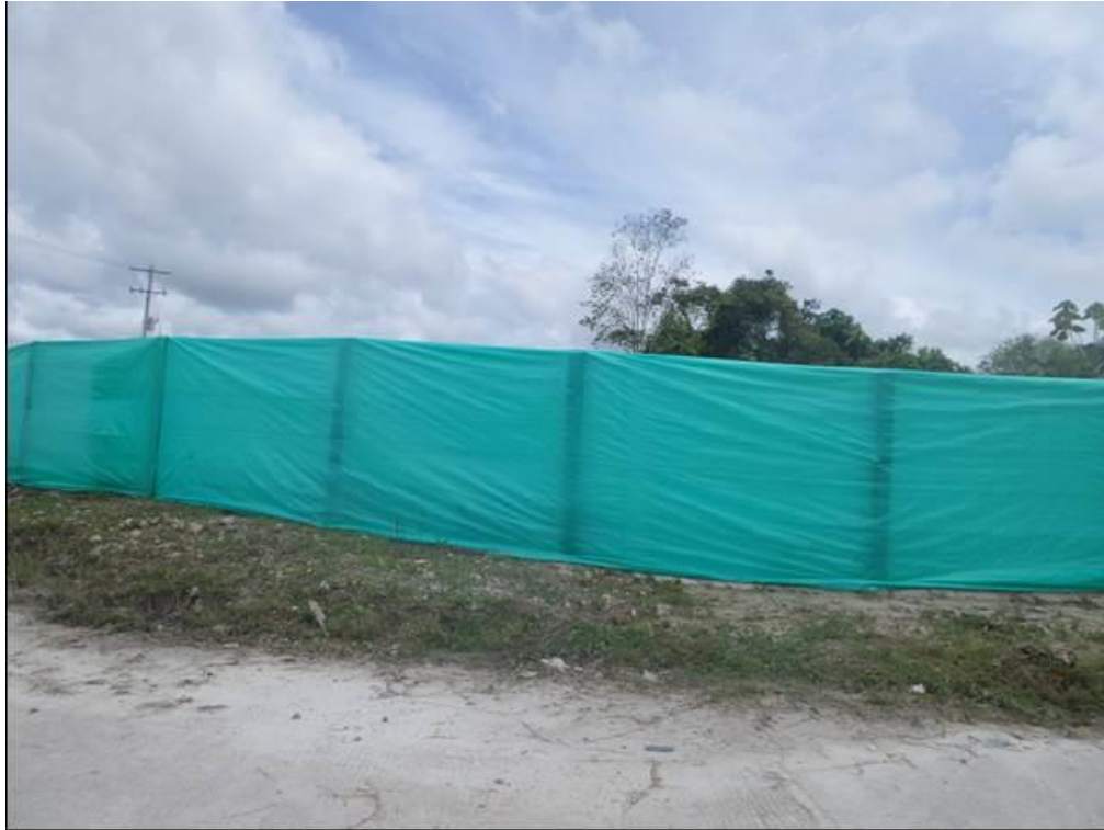
Foto 1. Cerramiento en lona verde sobre cerca.
