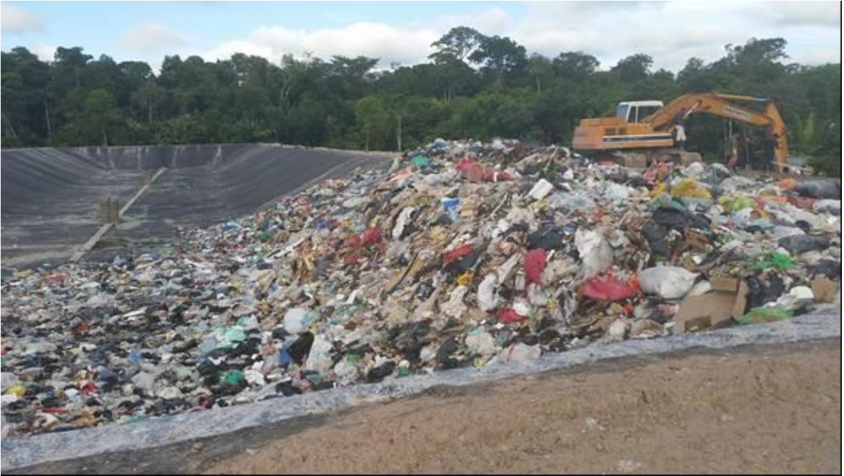
Foto 3. Vista operación trinchera 5.
