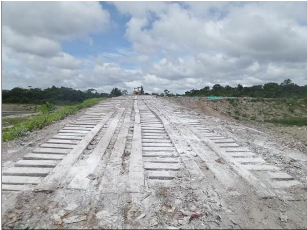
Foto 4. Rampa a trinchera No. 5
