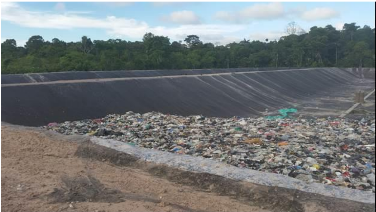
Foto 2. Trincheras 5 en operación.
