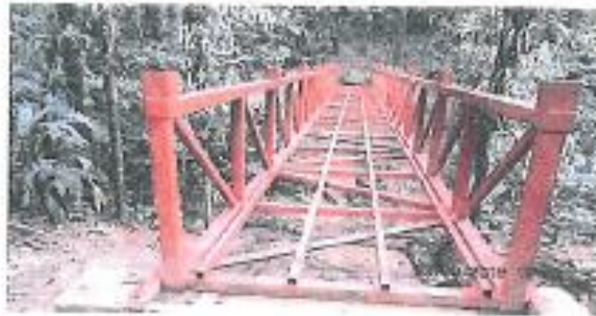
12. CONSTRUCCION DE PUENTE CORTO No 2.
