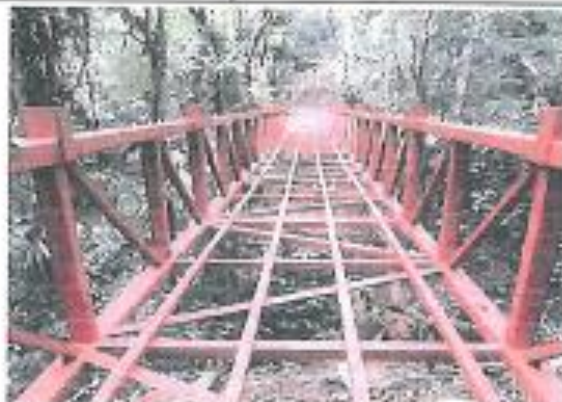
13. CONSTRUCCION DE MIRADOR DE AVES DE TRES NIVELES.
