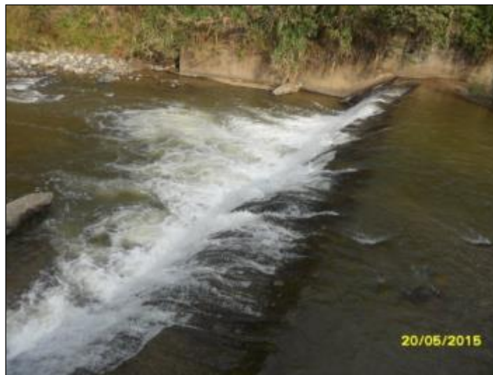
Imagen 4-1 Captación Sistema Hidroeléctrica Cedelca Sobre El Rio Palo
