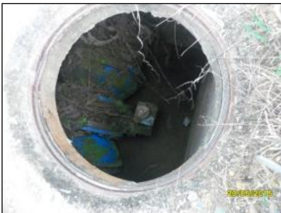
Cámara de entrada al tanque
