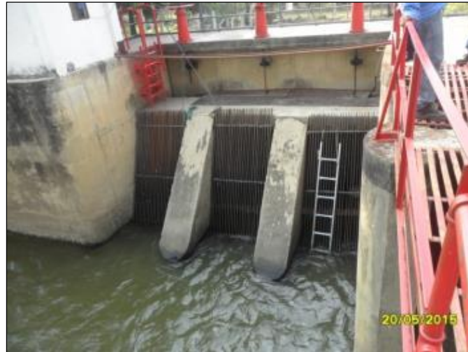
Imagen 4-2 Estructura de Derivación Lateral Sistema Hidroeléctrica Cedelca (Q Promedio 5 M 3 /S)
