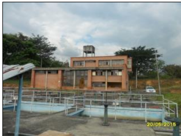
Imagen 4-8 Planta de tratamiento de agua potable empresa EARPA
